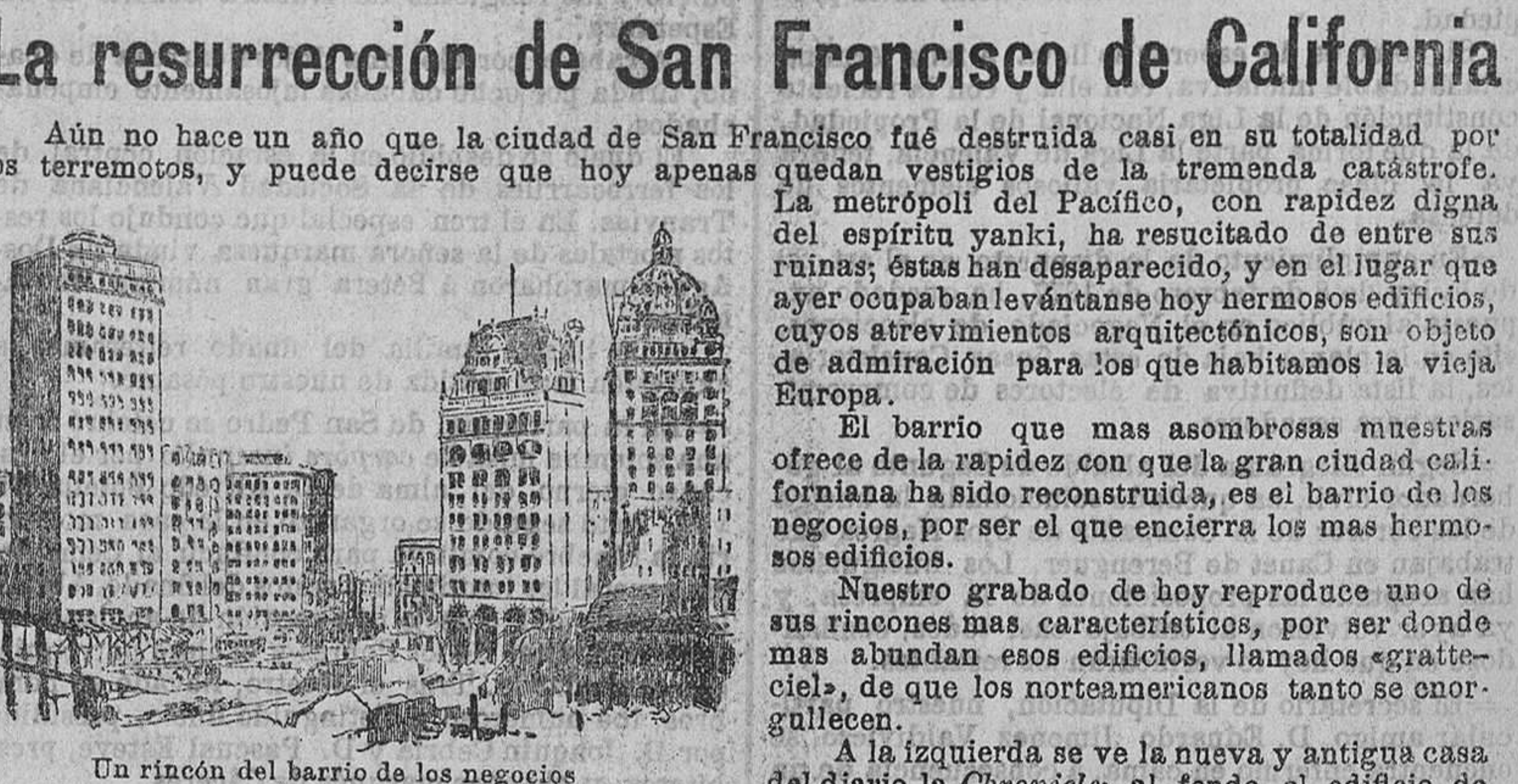
Un rincón del barrio de los negocios Mutual Bank y «La Call», sucesivamente, todos ellos construidos con viguetas de acero y cemento armado, como la mayoría de los inmuebles levantados en San Francisco, pues por lo ocurrido en abril último, los yanquis han sacado la consecuencia de que este sistema de construcción es el que mayores ventajas reune contra los movimientos sísmicos.
