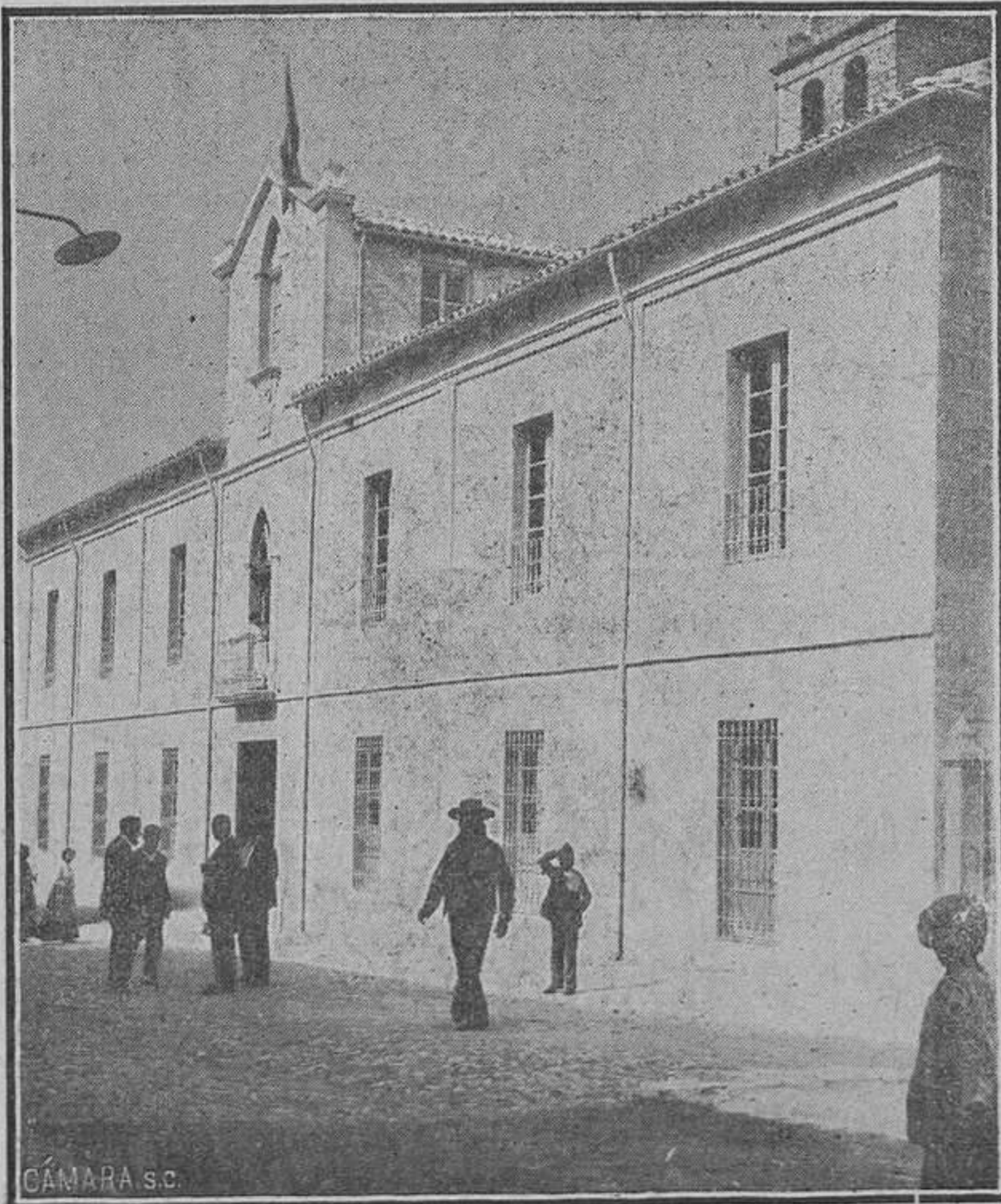
Edificio para Escuelas graduadas en Villacarrillo.
