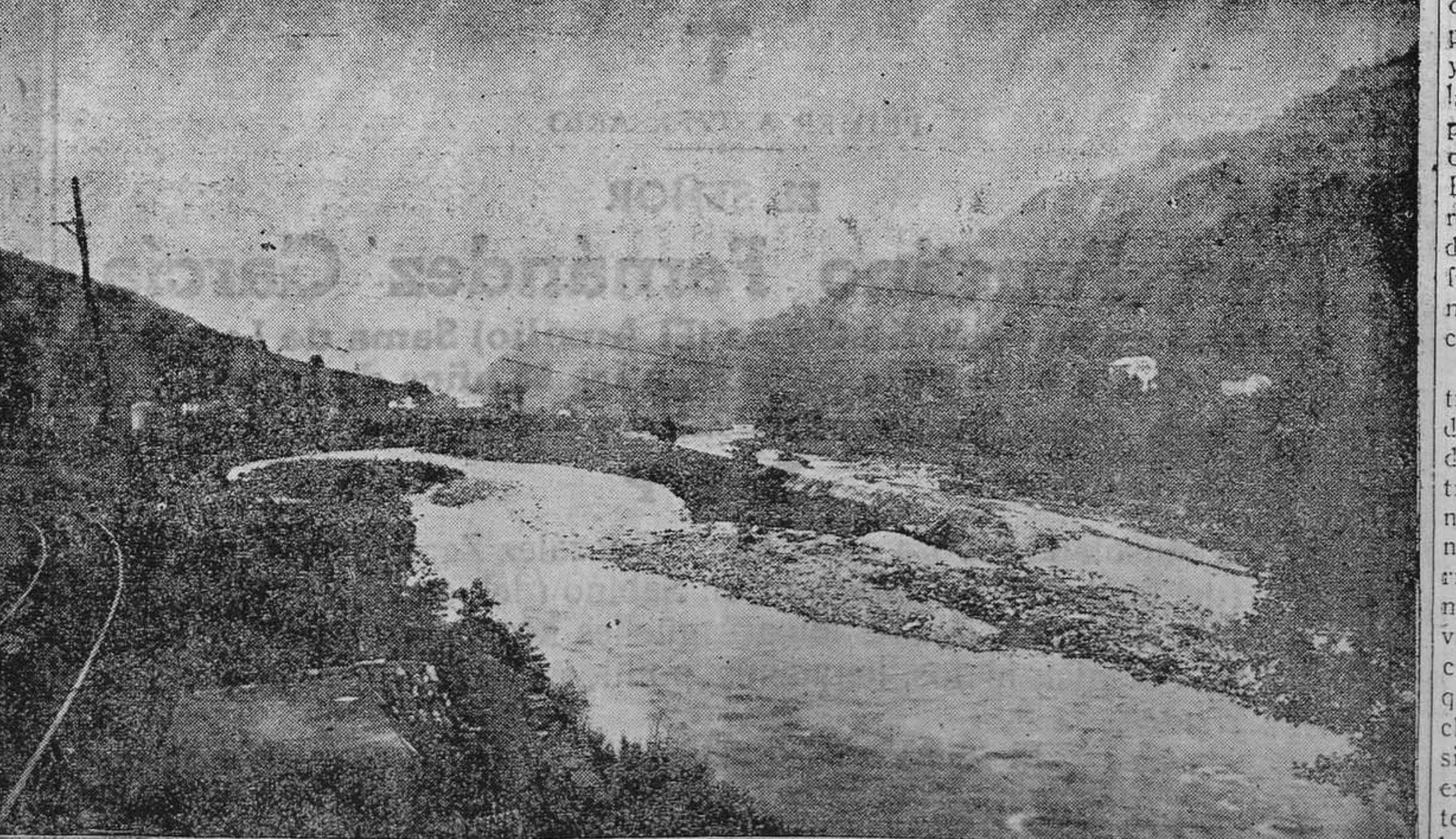
LA PROLONGACION DEL VASCO.—En esta "foto" se puede apreciar el notable beneficio que la nueva línea proporciona al pueblo de Santa Cruz. Está hecha cuando se había iniciado la construcción de la escollera con la que se ha desviado el cauce del río llevándolo hacia la izquierda del mismo y dejando secos y protegidos los terrenos que aquí desaparecen bajo la corriente. A la izquierda, la línea del ferrocarril de la Sociedad Industrial Asturiana que ahora será suprimido. (Foto C.)
