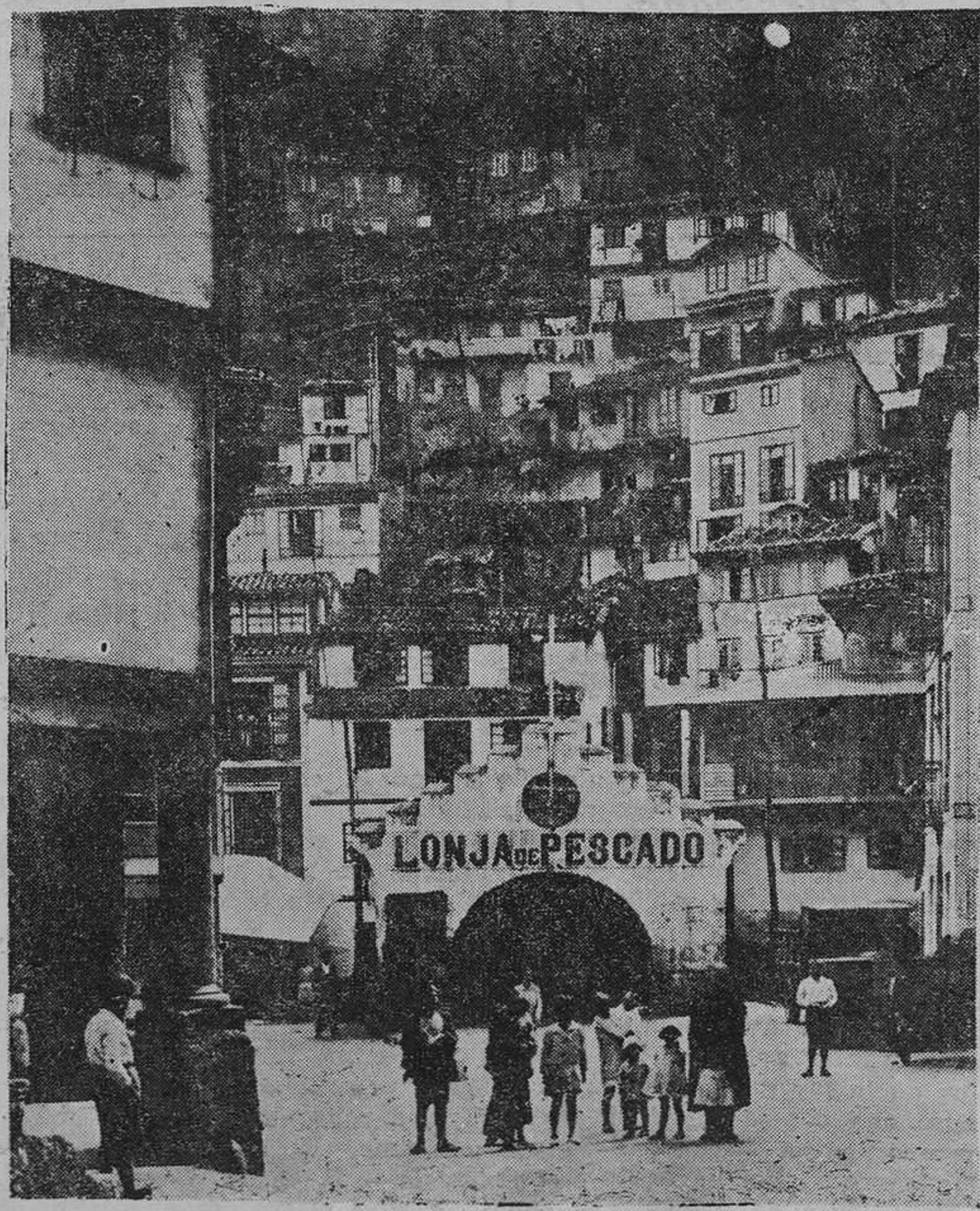
CUDILLERO.— La Lonja de Pesca. En ella está controlada toda la economía del pueblo. Entran en ella peces de irisadas escamas, que se convierten en plata acuñada todos los días en que la pesca copiosa llena las naves del edificio.
