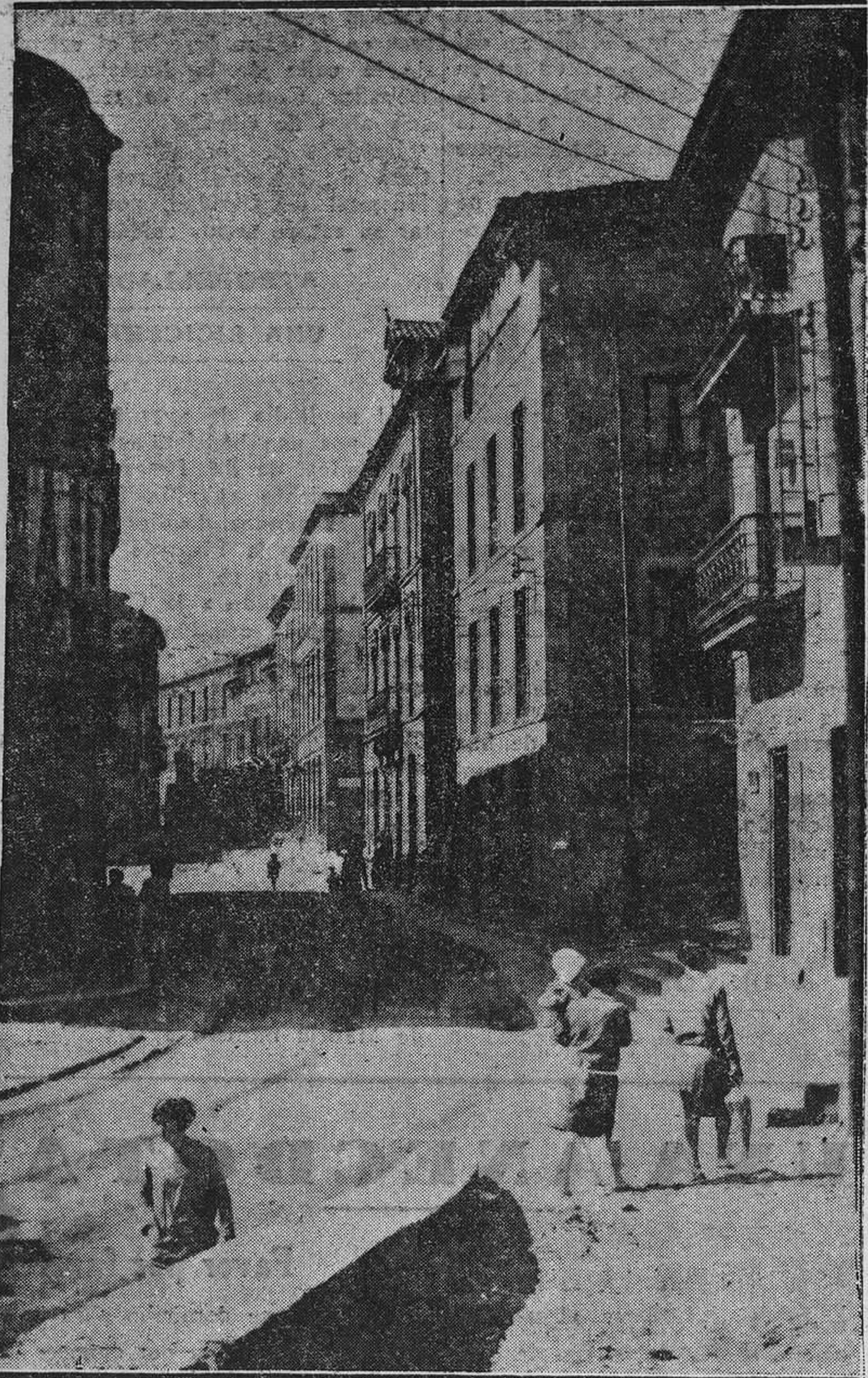
CANDÁS.—Calle Braulio del Busto, entrada al pueblo por la carretera de Gijón a Oviedo y que arranca de las inmediaciones del puerto
