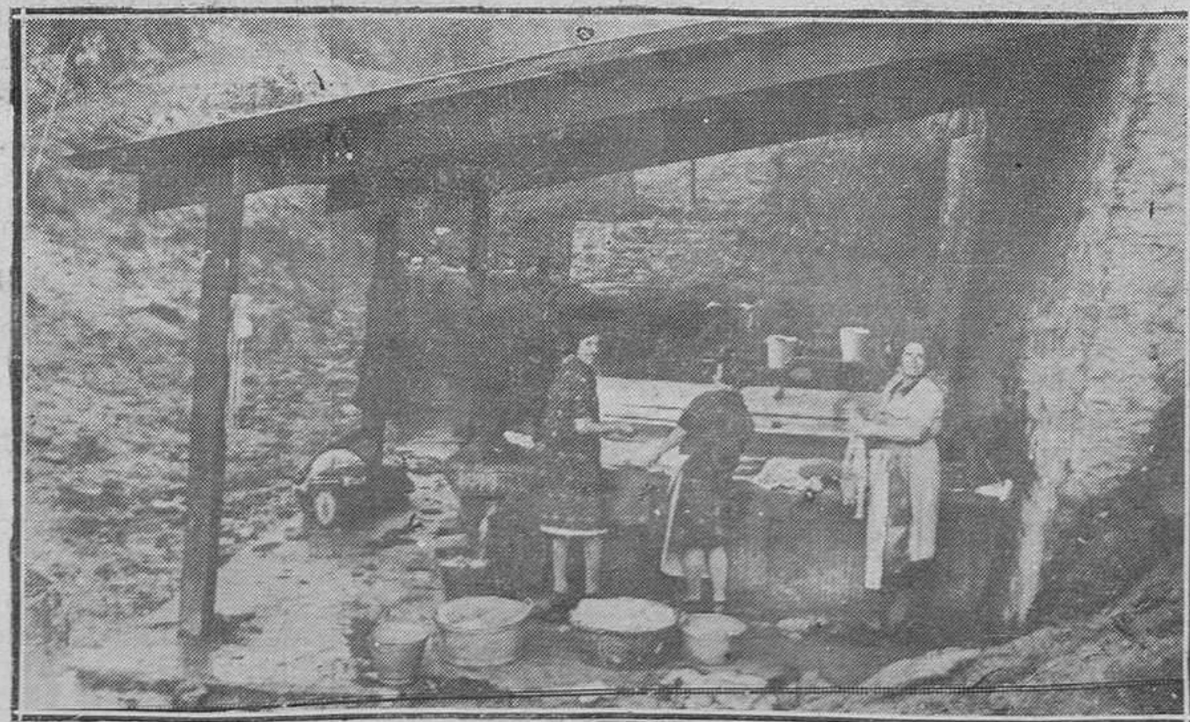
OLLONIEGO. — Lavadero de recientemente construcción que resulta insuficiente para las nece- (Foto Mena)
