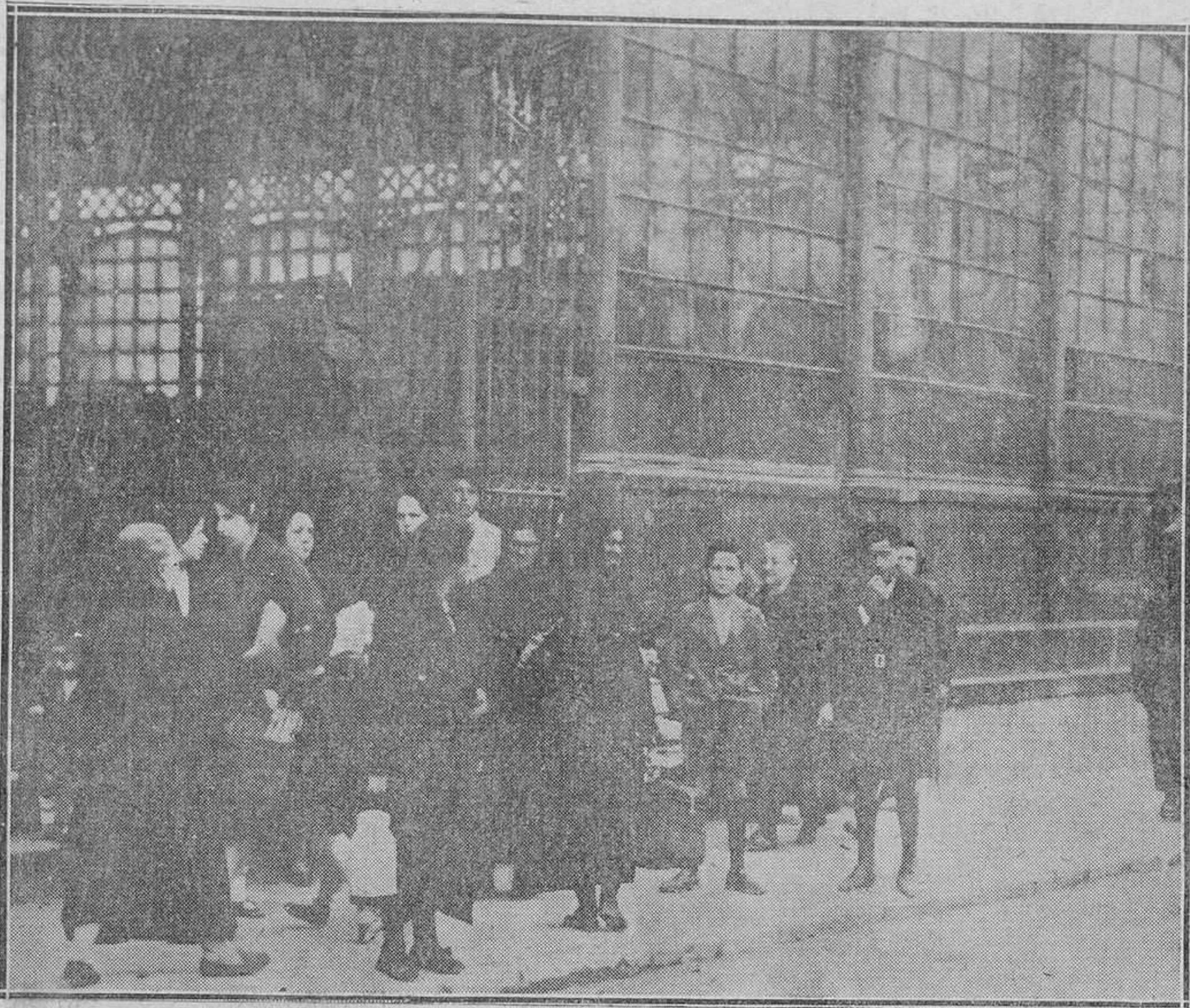
GIJON. — La plaza cubierta
