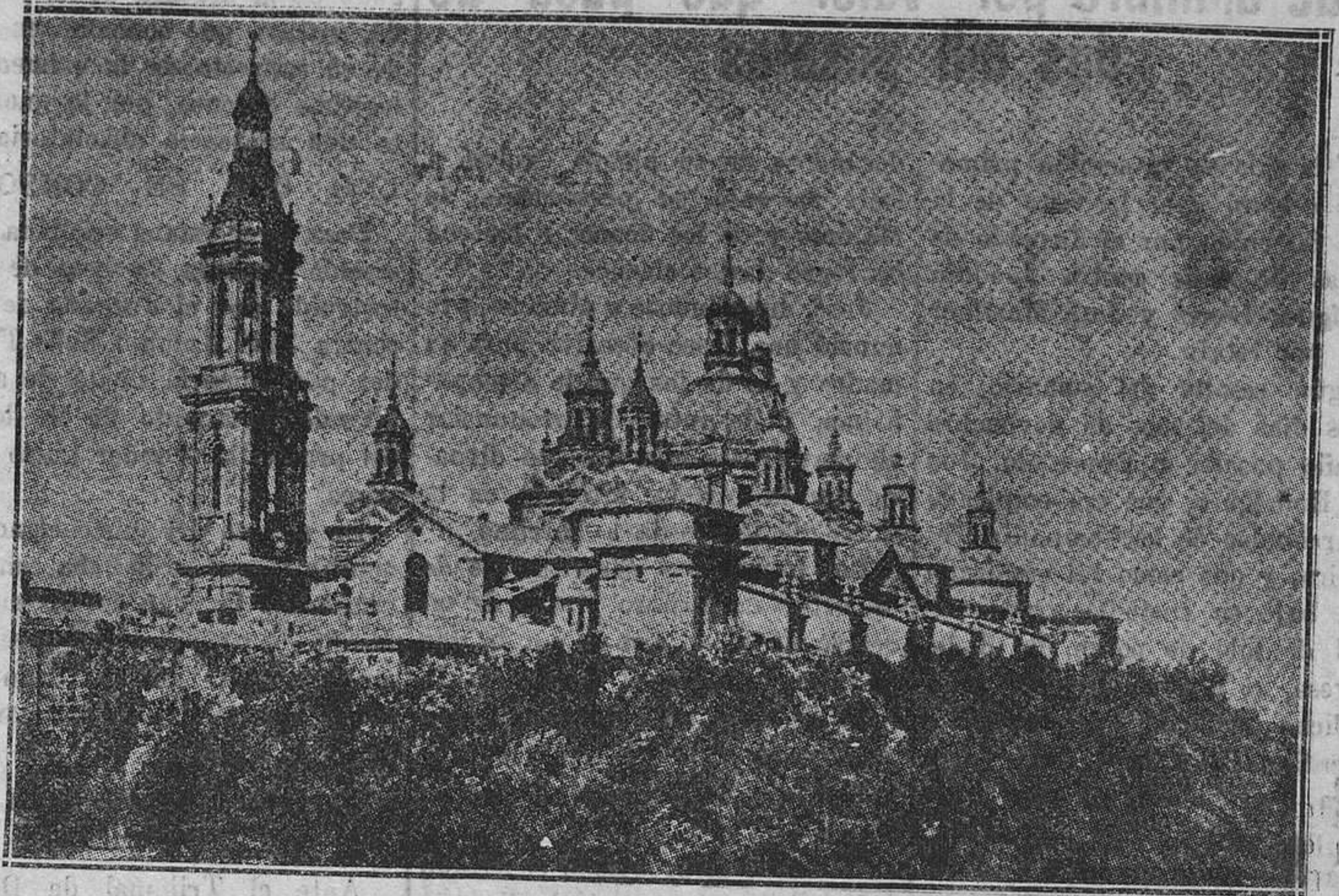
ZARAGOZA.— La Basílica del Pilar, que se cerrará al público durante las obras de reparación de este Santuario, por cuya seguridad llegó a temerse seriamente
