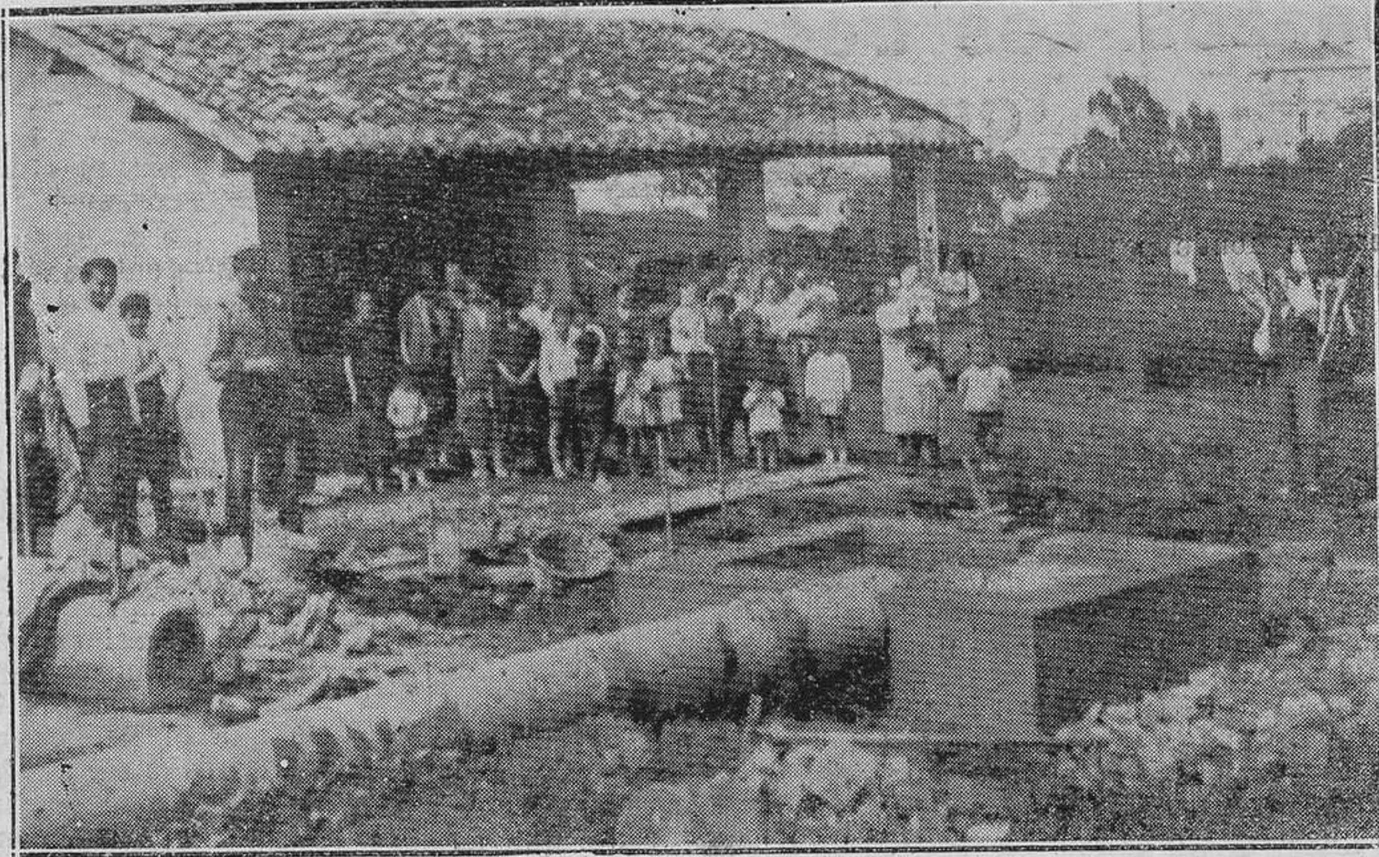
AVILES.-Lavadero y abrevadero de reciente construcción en los alrededores del manantial. (Mena)
