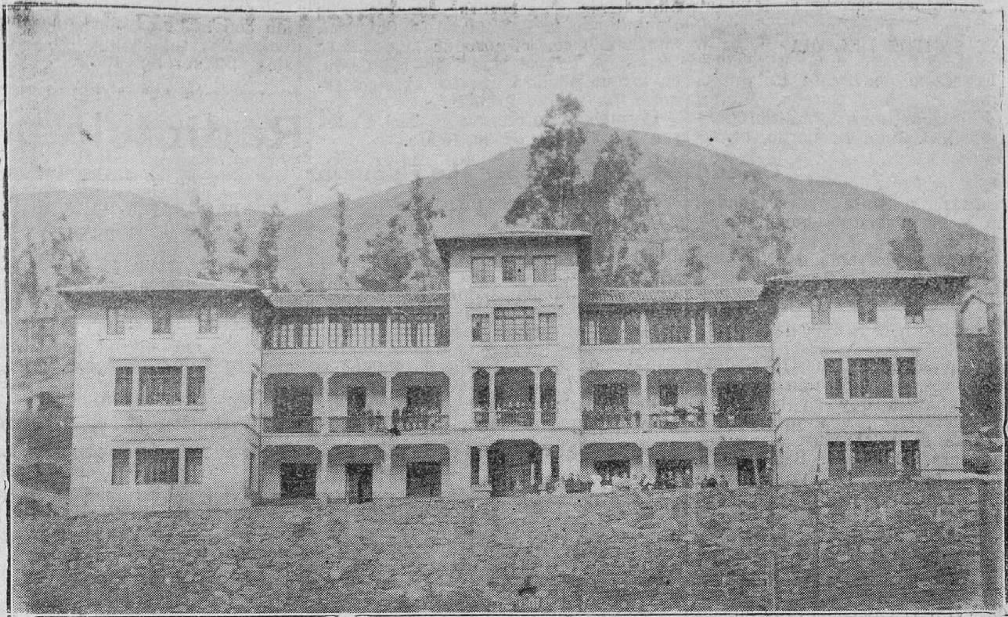
CABRANZA [ALLER]. Magnífico edificio construido a expensas de "Hullera Española" y dedicado a escuelas.
