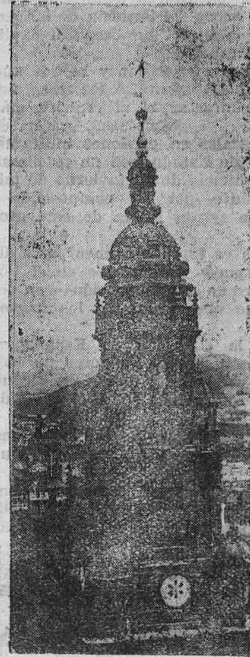
El escalatorres Massa Vaz, que mañana trepará por la Catedral, en el remate de la torre más alta de la Catedral de Santiago de Compostela.
