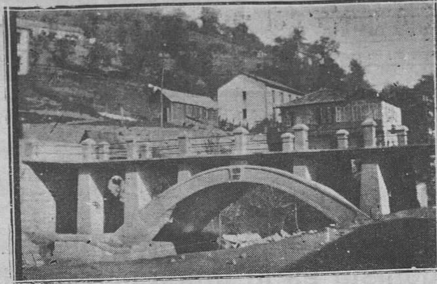
Magnífico puente de hormigón armado, construido por la S. A. Hurleras del Turón, y que une la carretera municipal de Figaredo a Urbiés con el barrio obrero de San Francisco.
