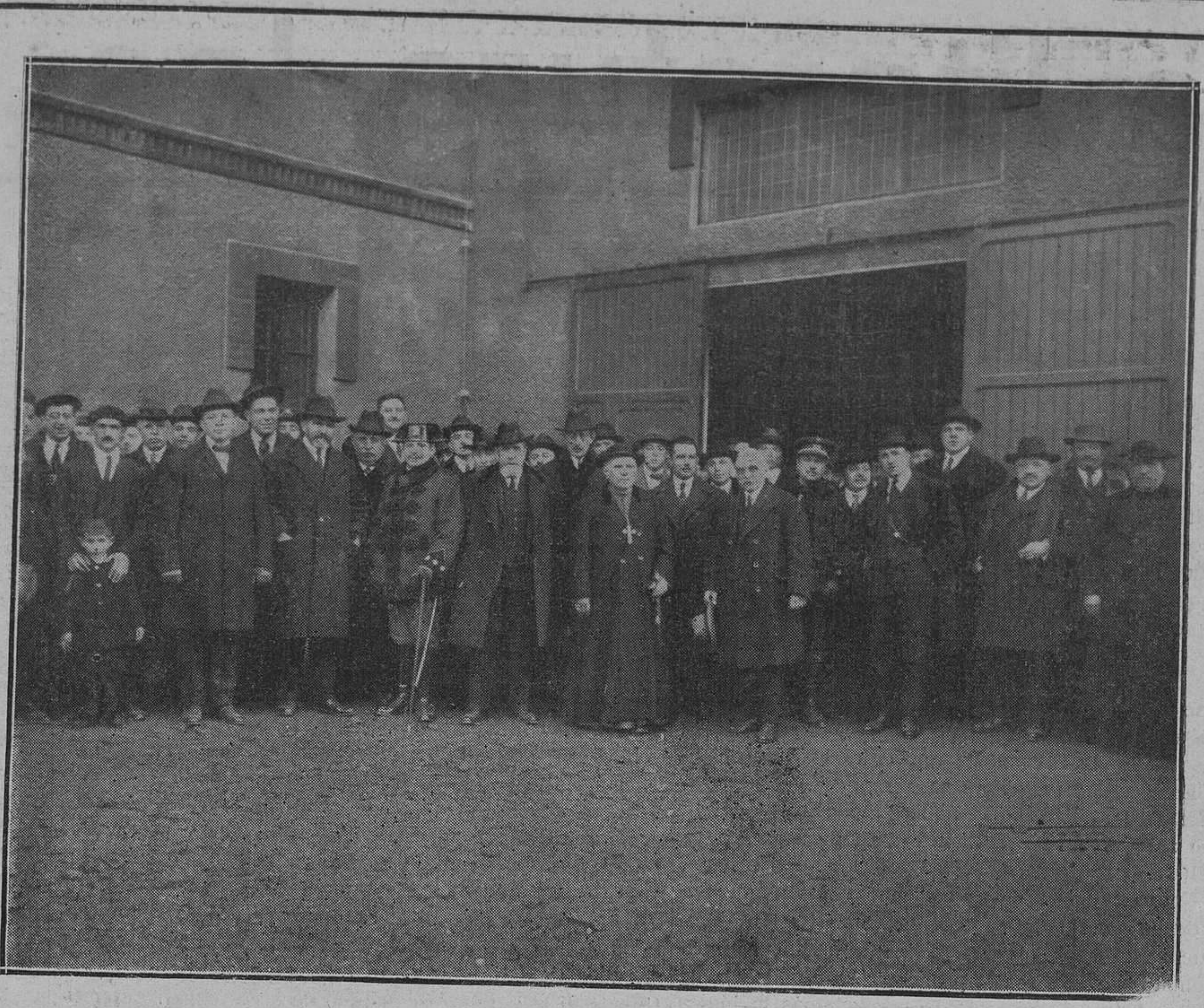
HIDROELÉCTRICA LEGIONENSE S. A.—Las autoridades y algunos accionistas después del acto de bendición de la Central.
