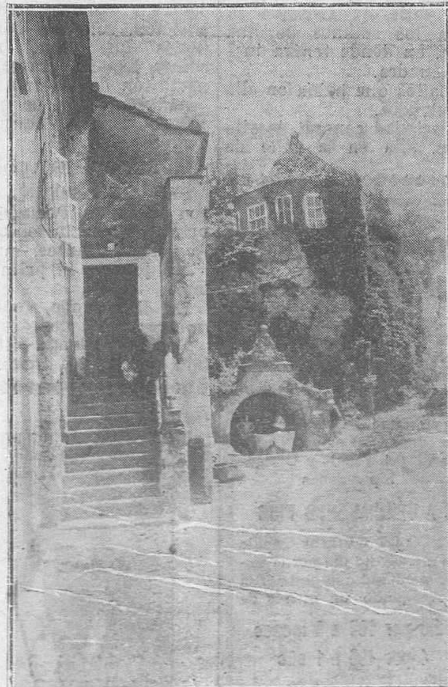
FIGUERAS. Un aspecto de la barriada de 'muelle'. (Foto Villar)
