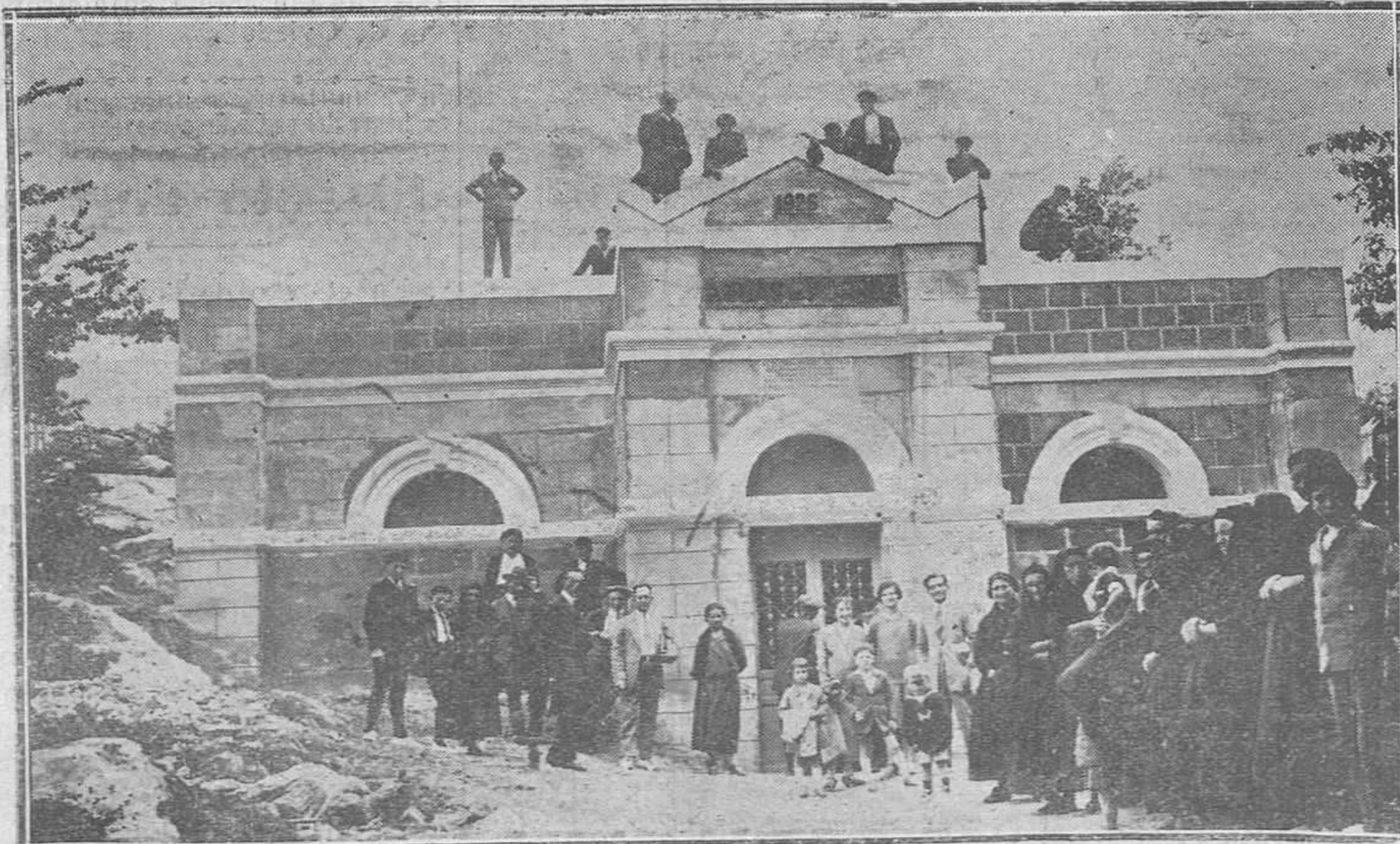
LLANES (PORRÚA).-El soberbio depósito de aguas, capaz para 300 metros cúbicos, que fué solemnemente inaugurado el día 9 del corriente mes. (Foto Rozas)
