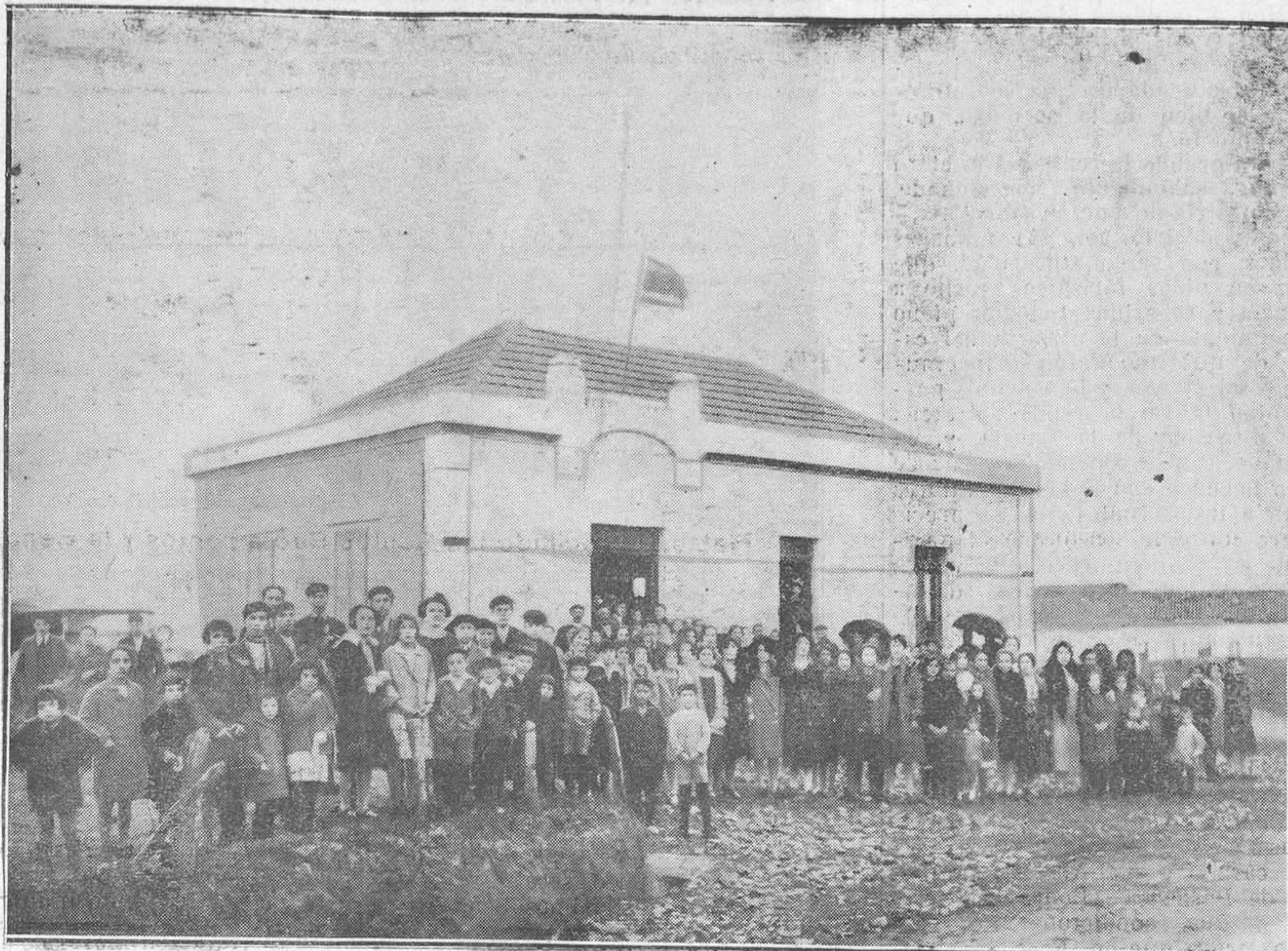
RANON (SOTO DEL BARCO).-Edificio-casino inaugurado el 6 del corriente. [Foto M. G. Alonso]
