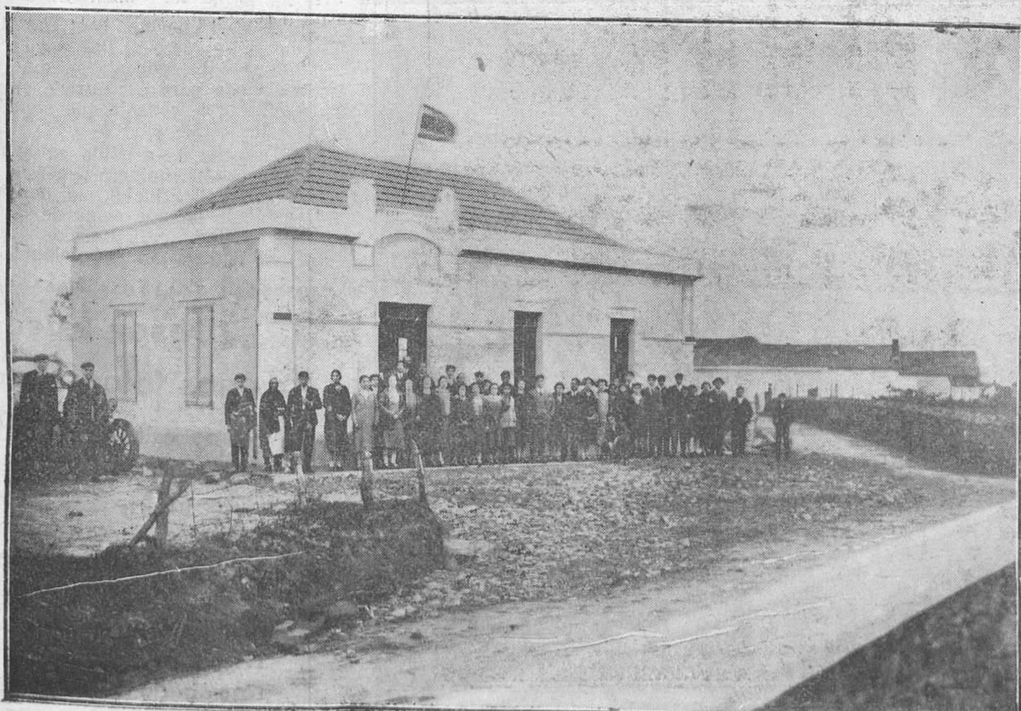
RANON (SOTO DEL BARCO).-Inauguración del edificio-casino. Foto M. G. Alonso
