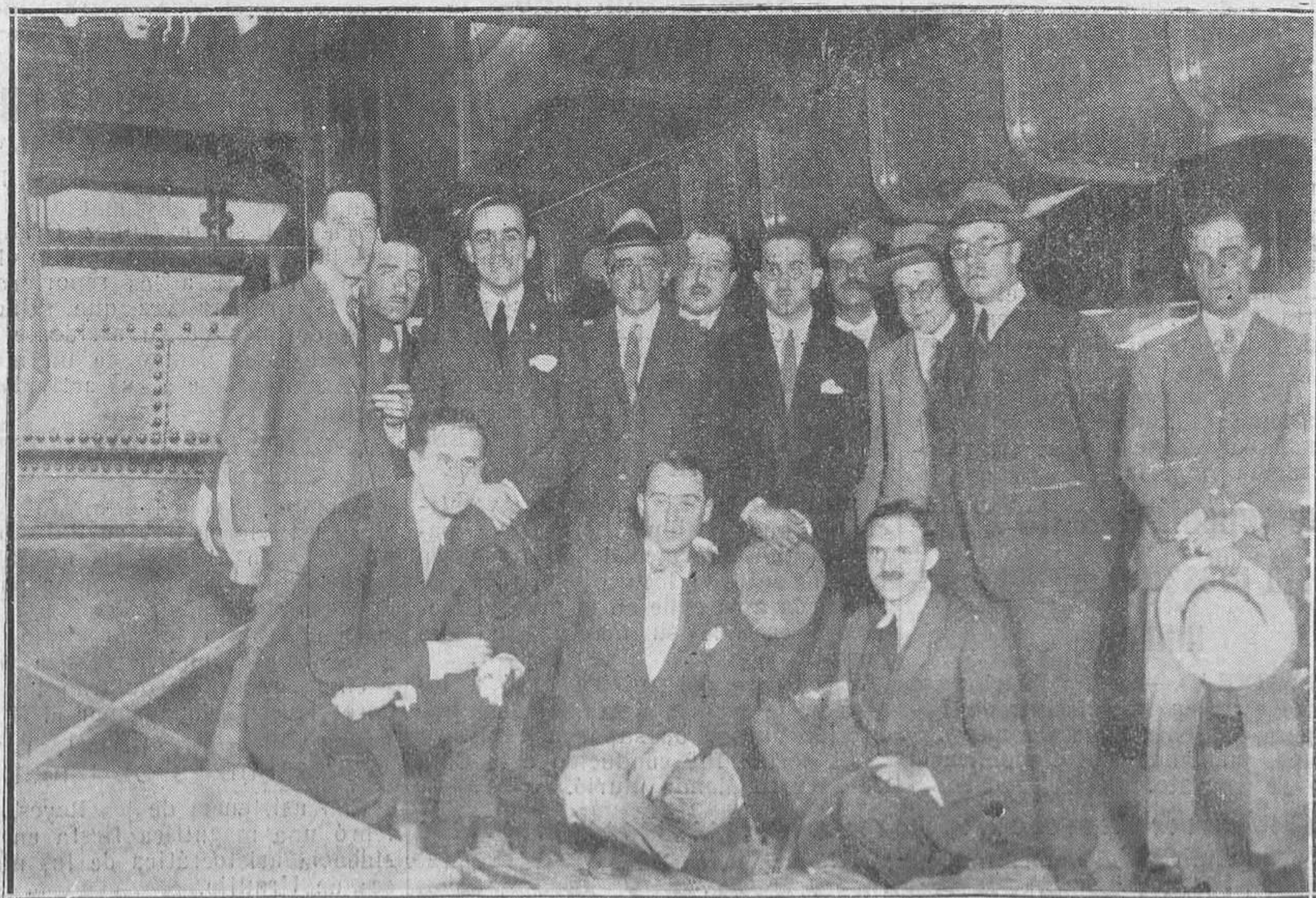
TURÓN.-Grupo de ingenieros y periodistas, rodeando al señor Fuentes Pila, en los nuevos lavaderos de Hulleras del Turón. Estos lavaderos son de construcción española y los mejores de la nación. (Foto Buella)
