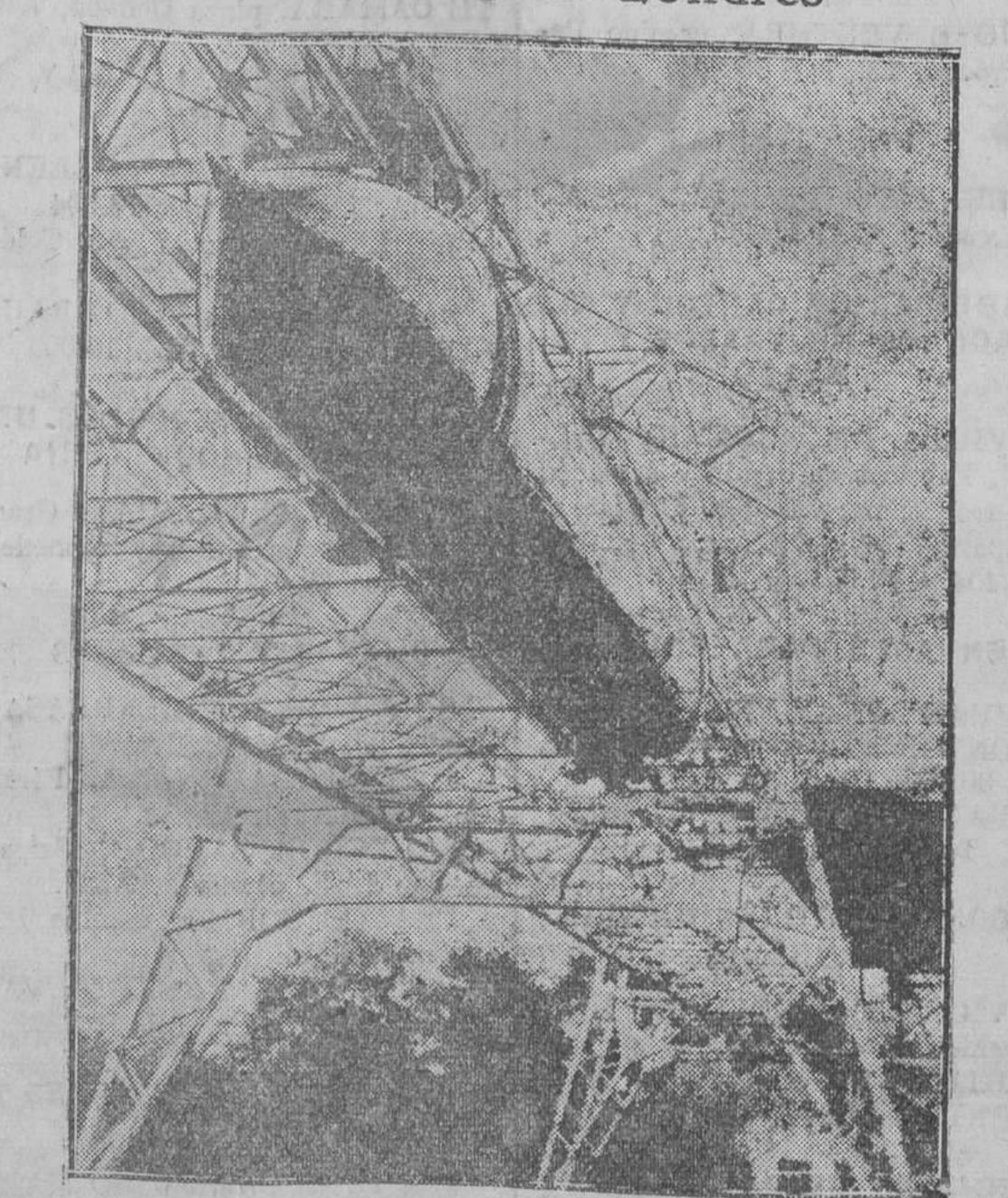
Demostración de un sistema de transportes que se piensa establecer en Londres. Los vagones están suspendidos en poleas que ruedan sobre un riel superior. Los carros están provistos de hélices, delante y detrás, y los motores son se mejantes a los del aeroplano
