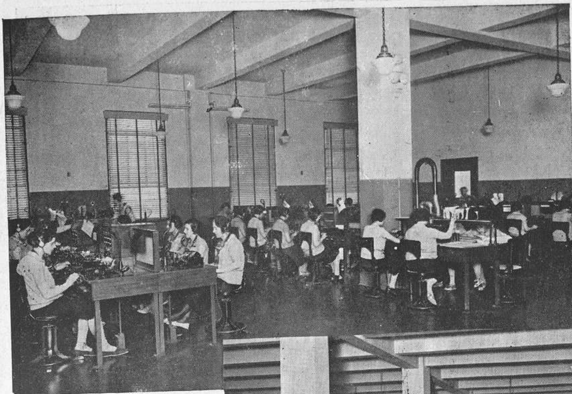
Sala de teléfonos, donde pueden trabajar al mismo tiempo 50 señoritas, cuando las necesidades del tráfico así lo exigen.
