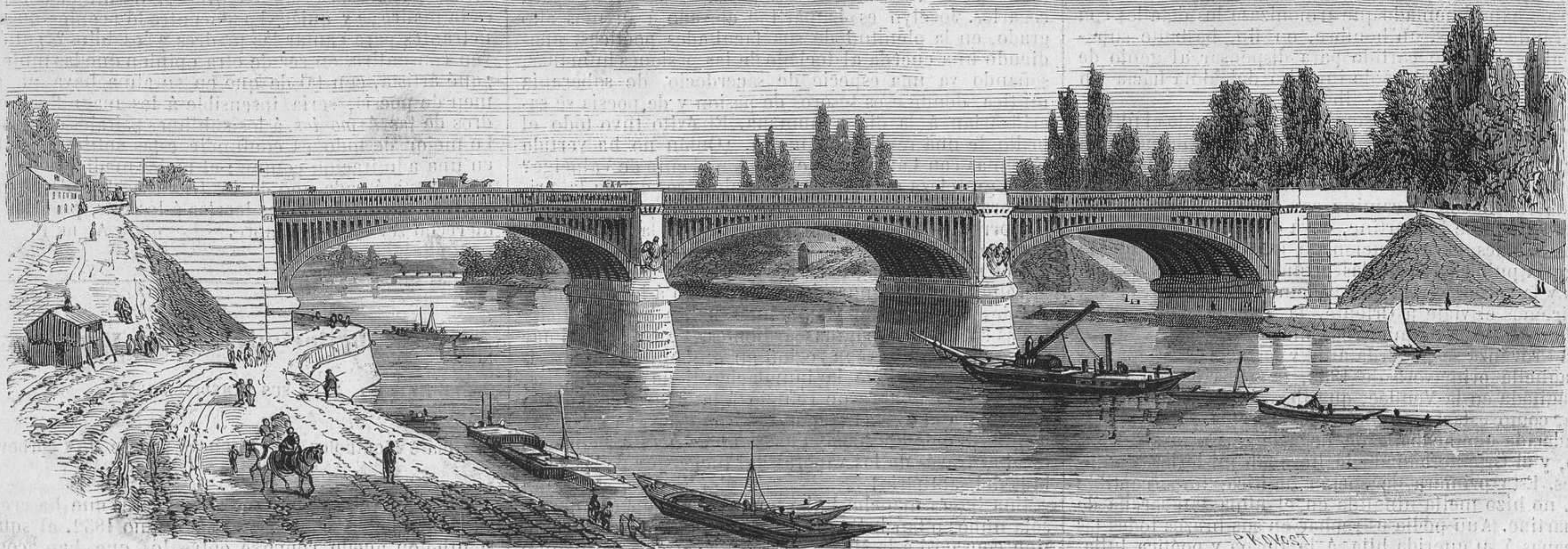
Cercanías de Paris. — El nuevo puente de Courbevoie.
