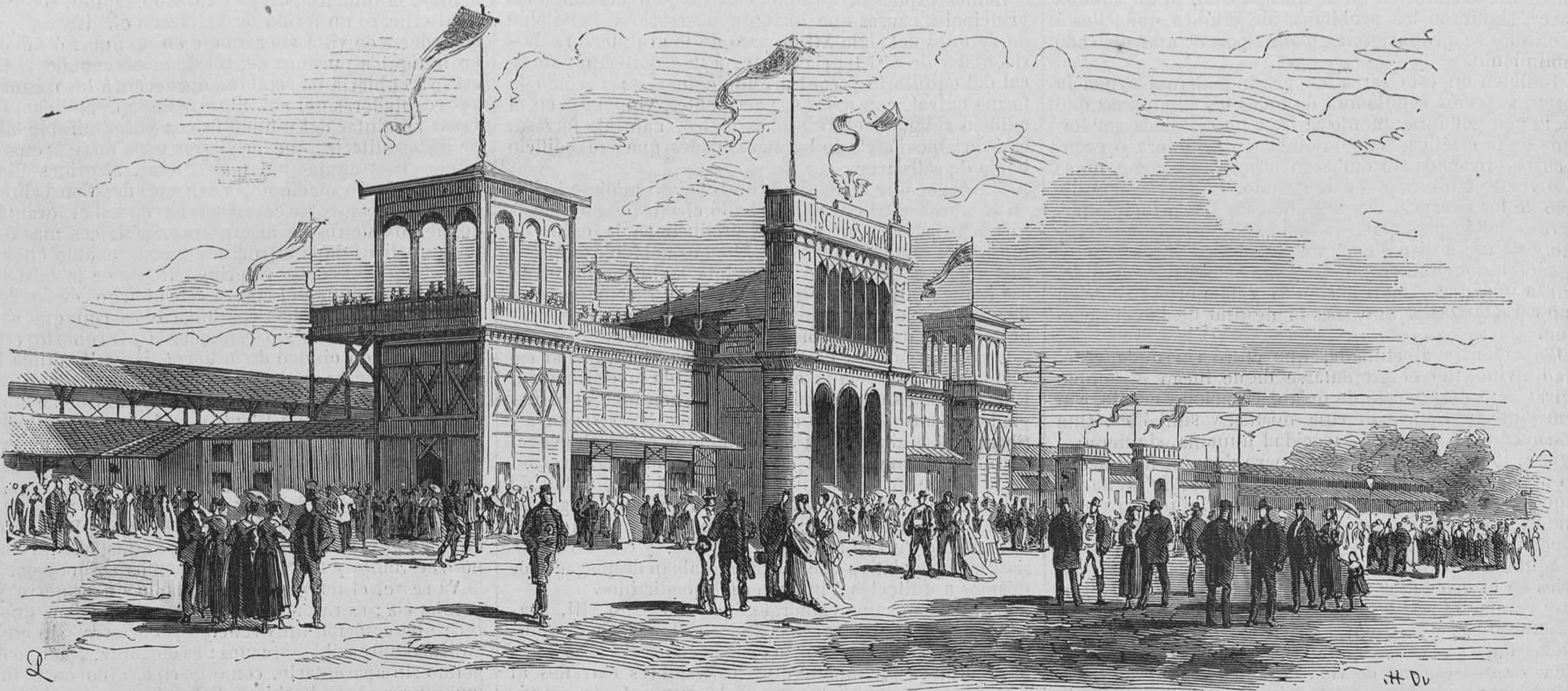
EL TIRO FEDERAL EN VIENA. — Vista exterior de la sala del tiro.
