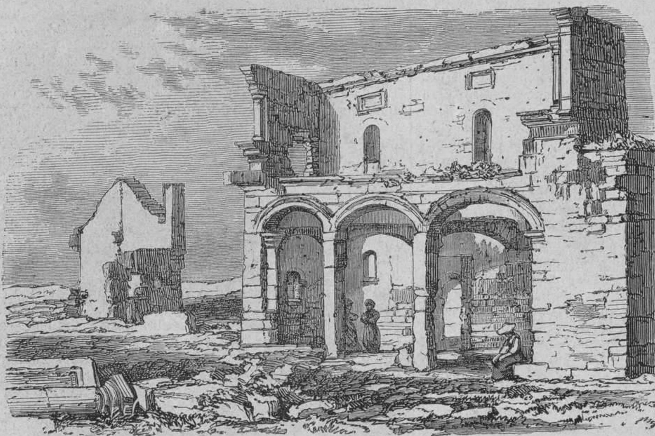
Ruinas del hospital.
