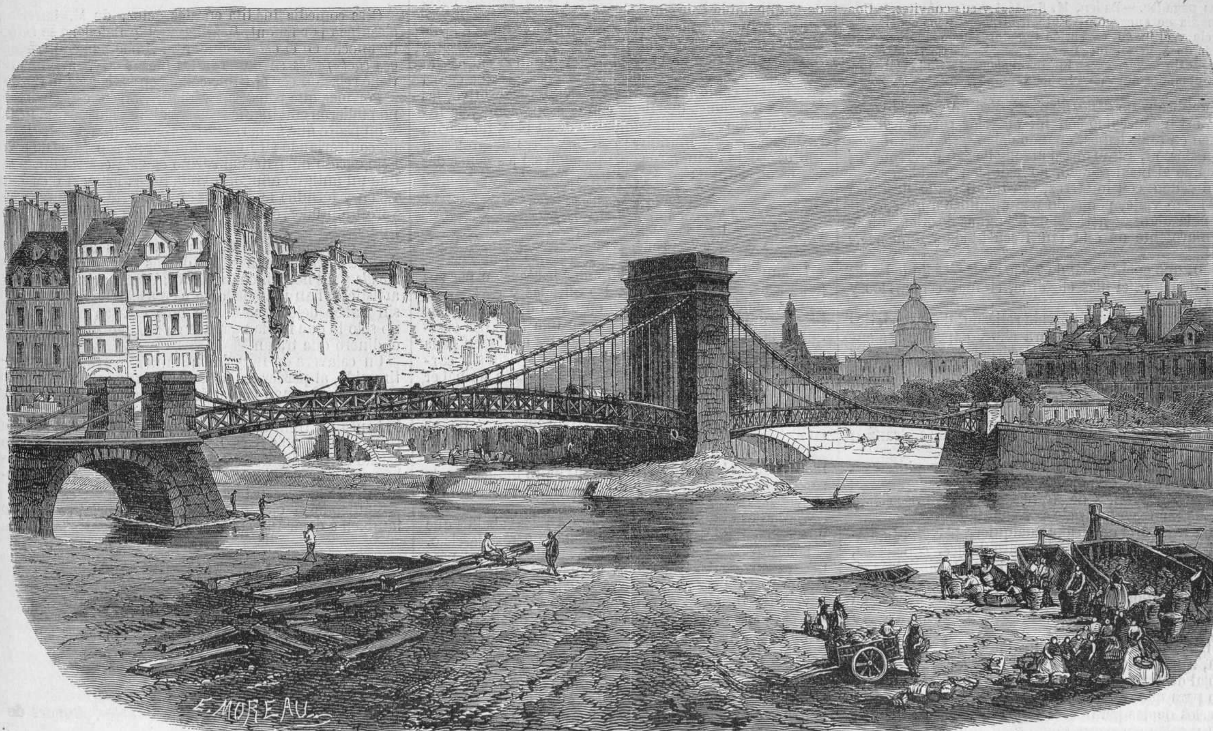
EL PUENTE DE LUIS FELIPE EN PARIS, DESTINADO A SER DEMOLIDO ; ESTADO ACTUAL DE LAS OBRAS DEL NUEVO PUENTE DE LA ISLA SAN LUIS.
