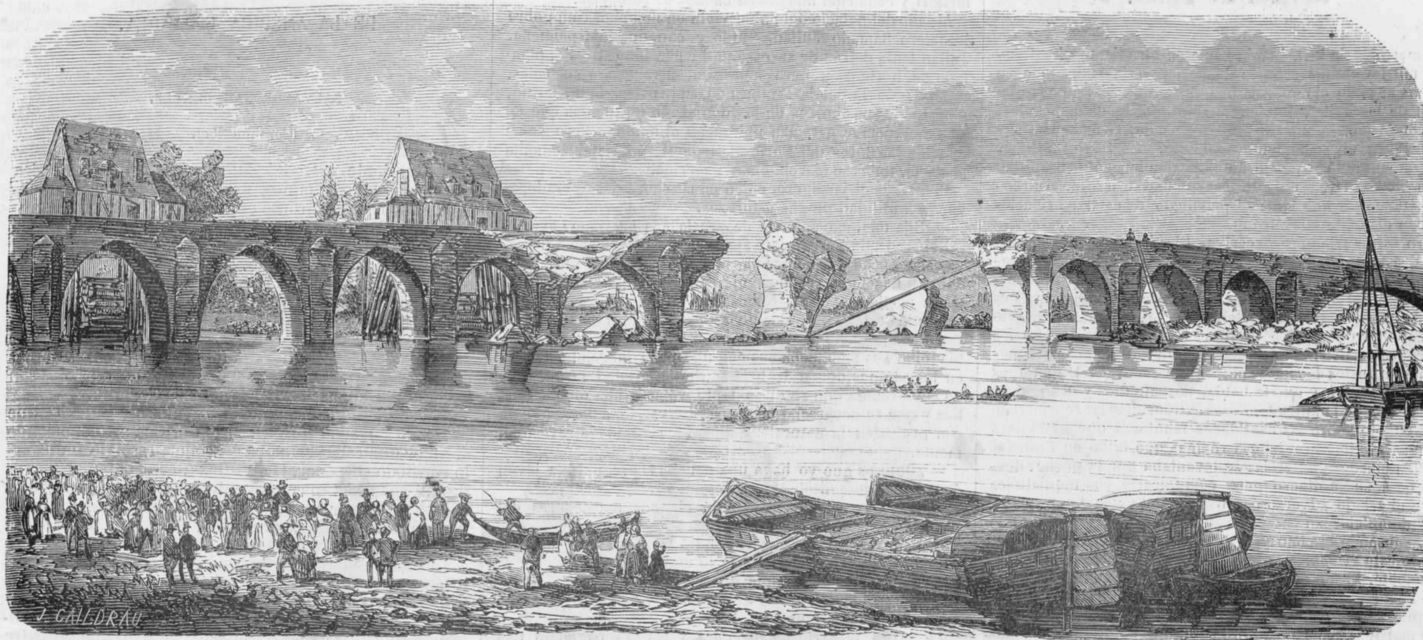
Hundimiento del puente de la aldea de Pont-de-l'Arche.
