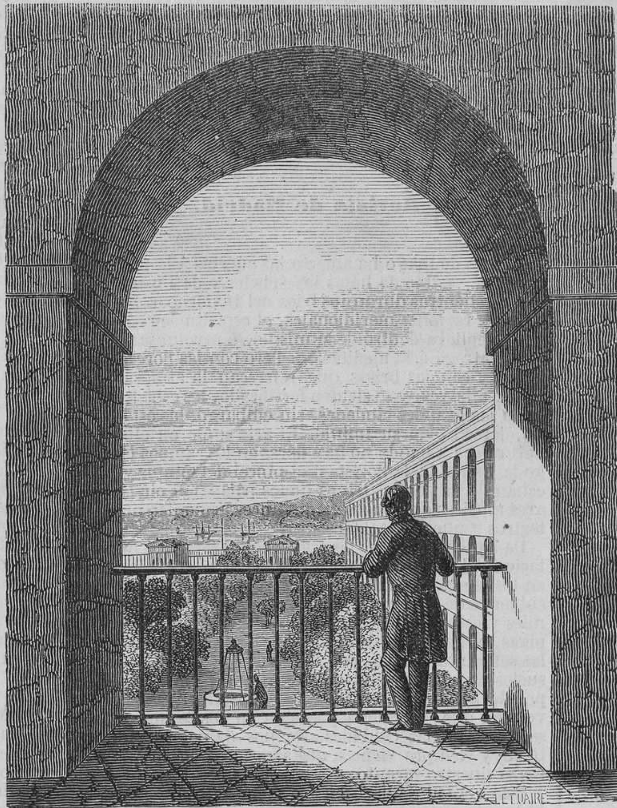
Una fachada del edificio, desde la galería del fondo.
