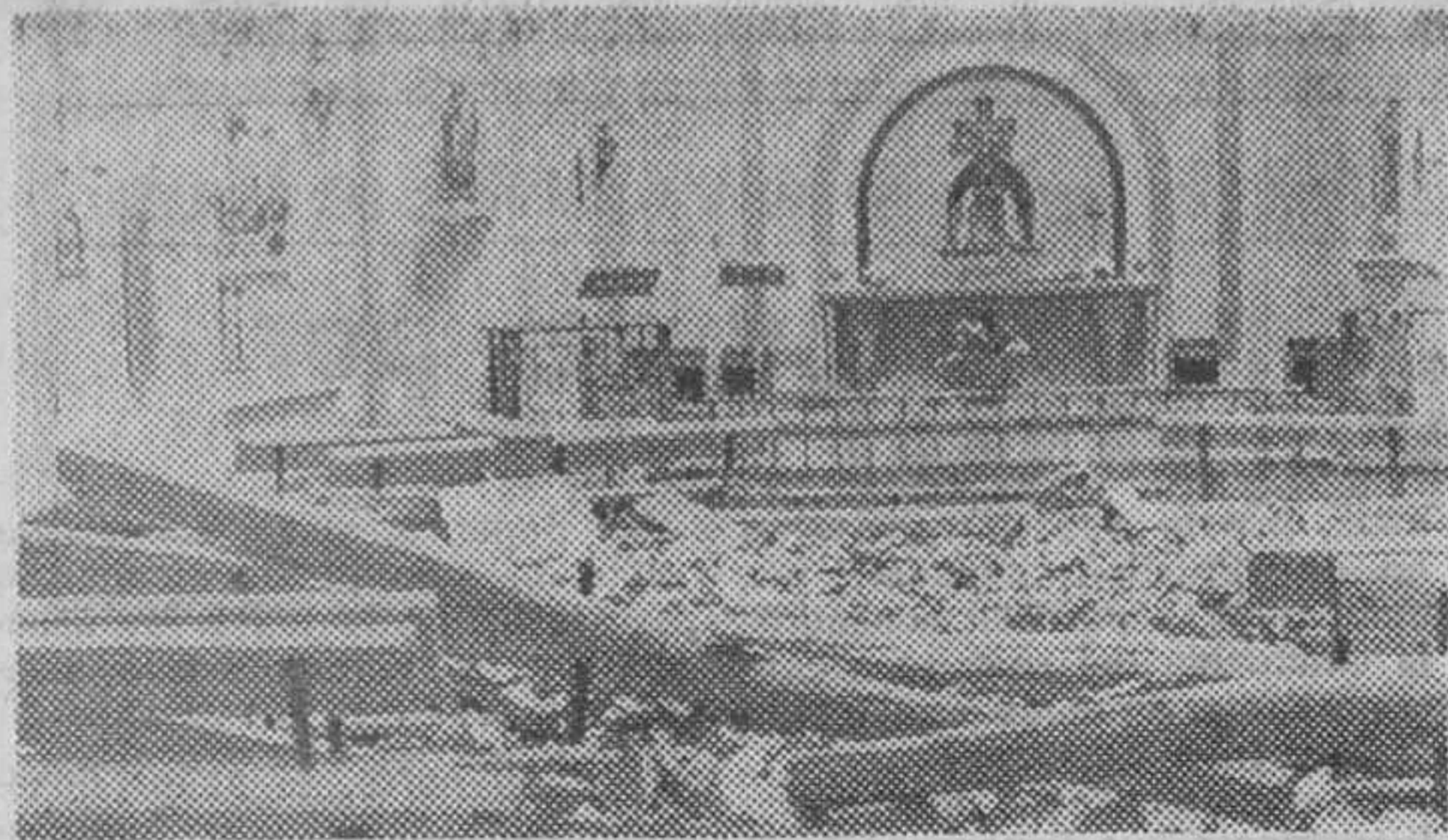
Ullastrell: Les cayó encima una viga de 12 metros
