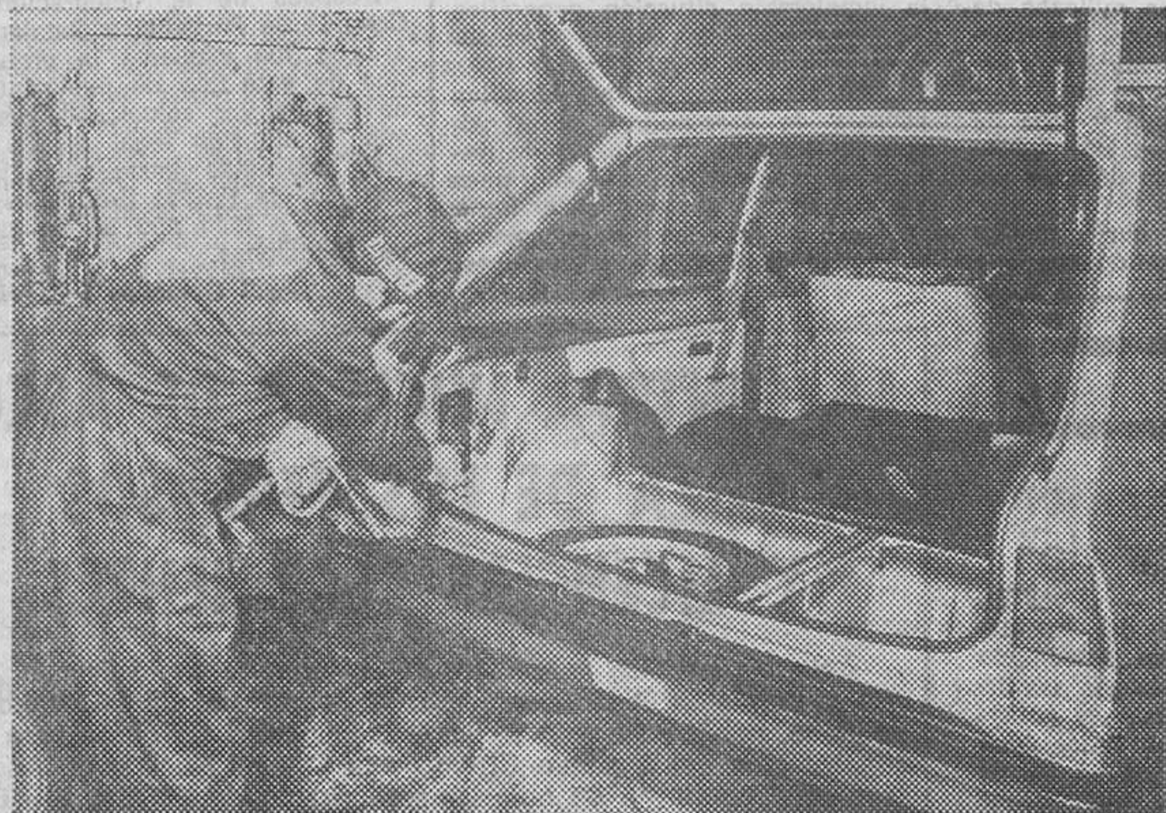
Inyección Dinitrol ML partes interiores de los laterales
