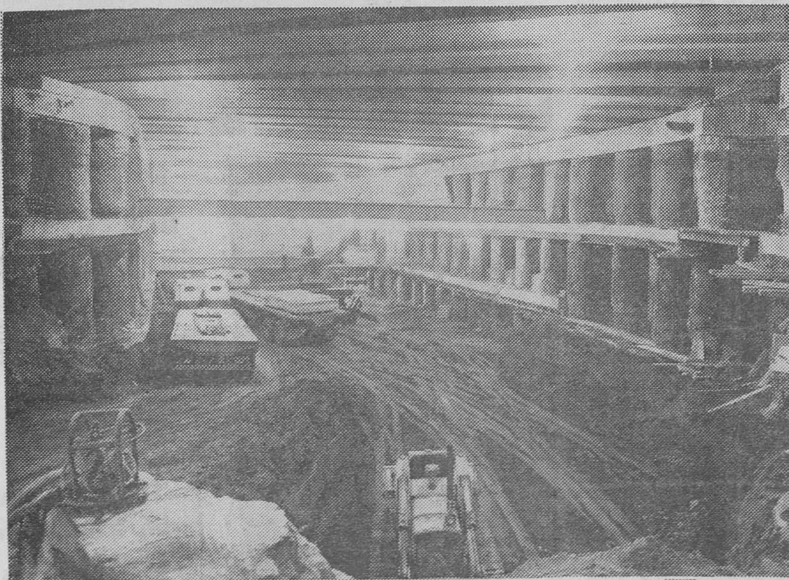
Camiones "trailers" descargando vigas y placas de encofrados, que fueron izadas por gruas a sus diversos lugares de emplazamiento.
