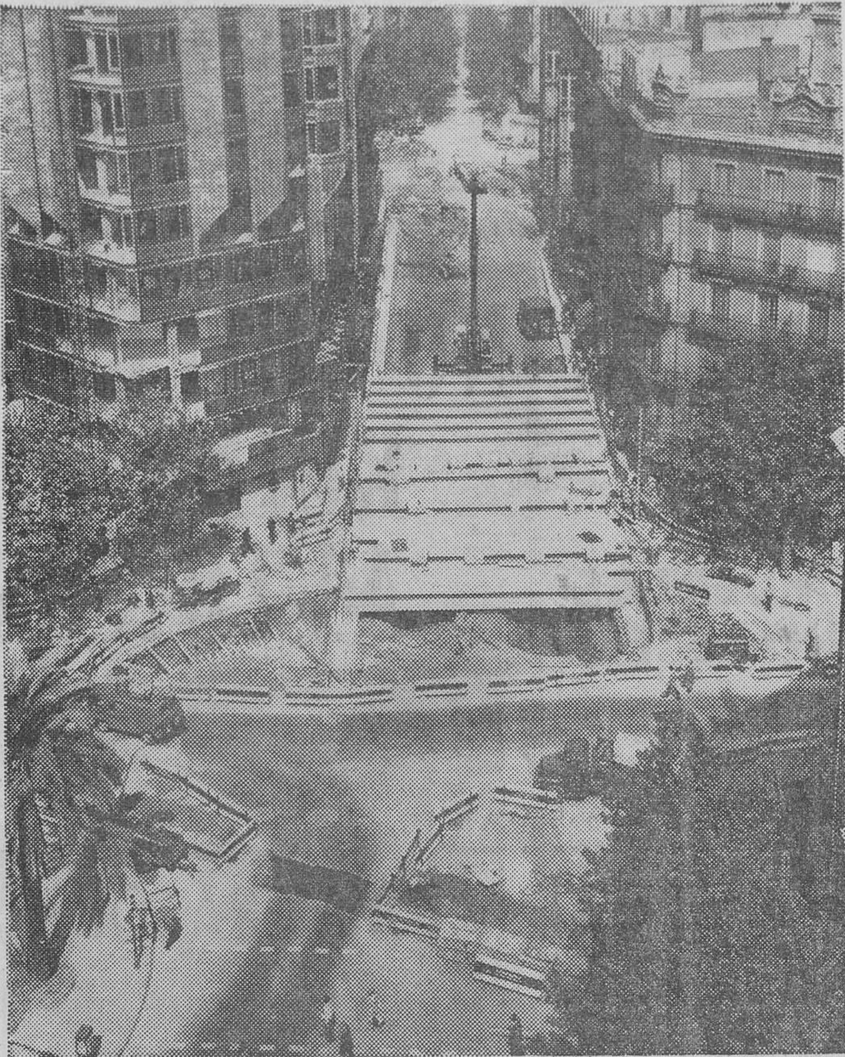
Colocación de las vigas de la calle Lauria, cortada al tráfico solo durante 45 días.
