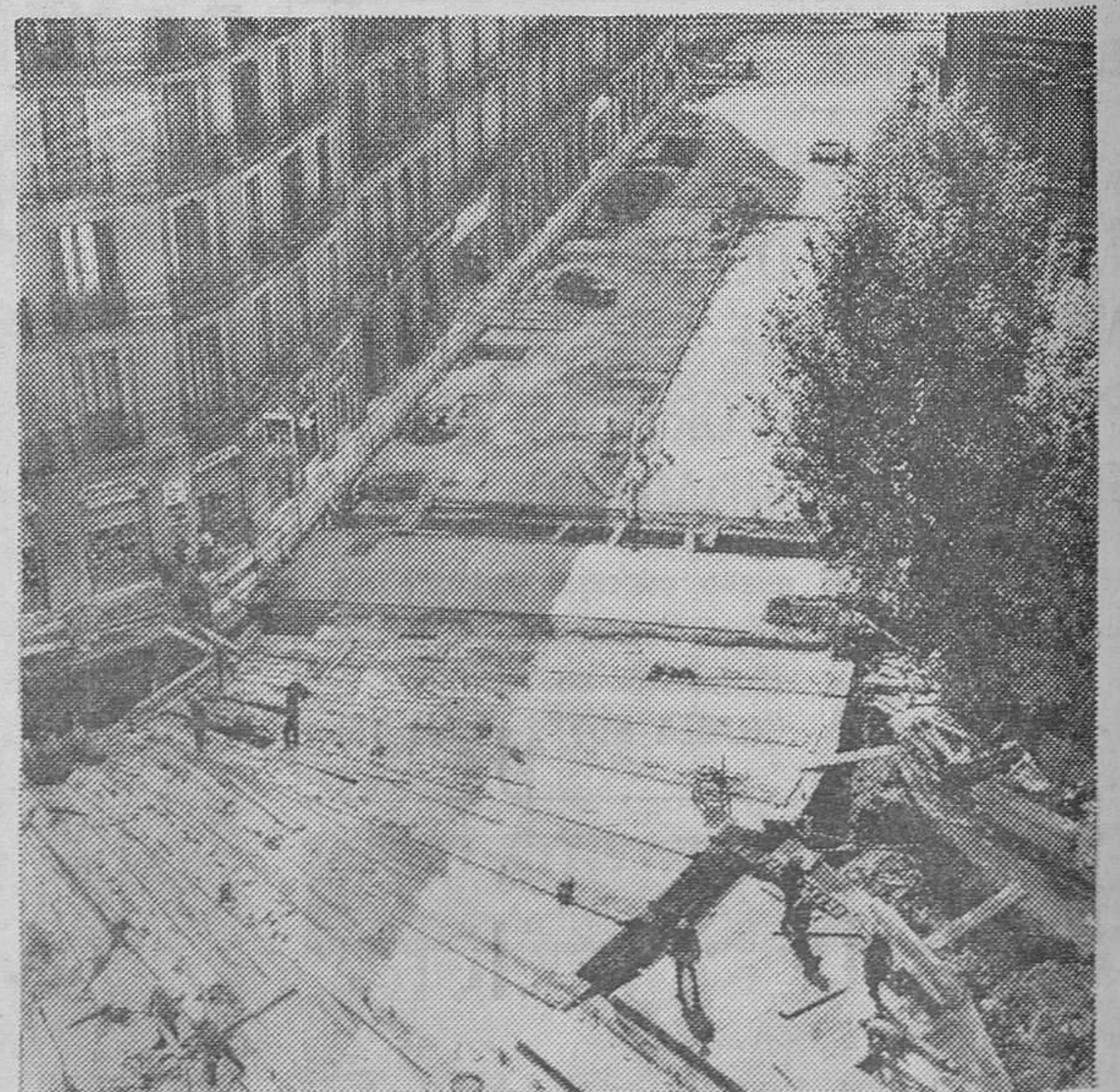
Después de colocadas las vigas en la calle Caspe, se pasó a hormigonar el forjado y a colocar la capa de rodadura de aglomerado asfáltico. Nótese los huecos dejados para la posterior plantación de árboles.
