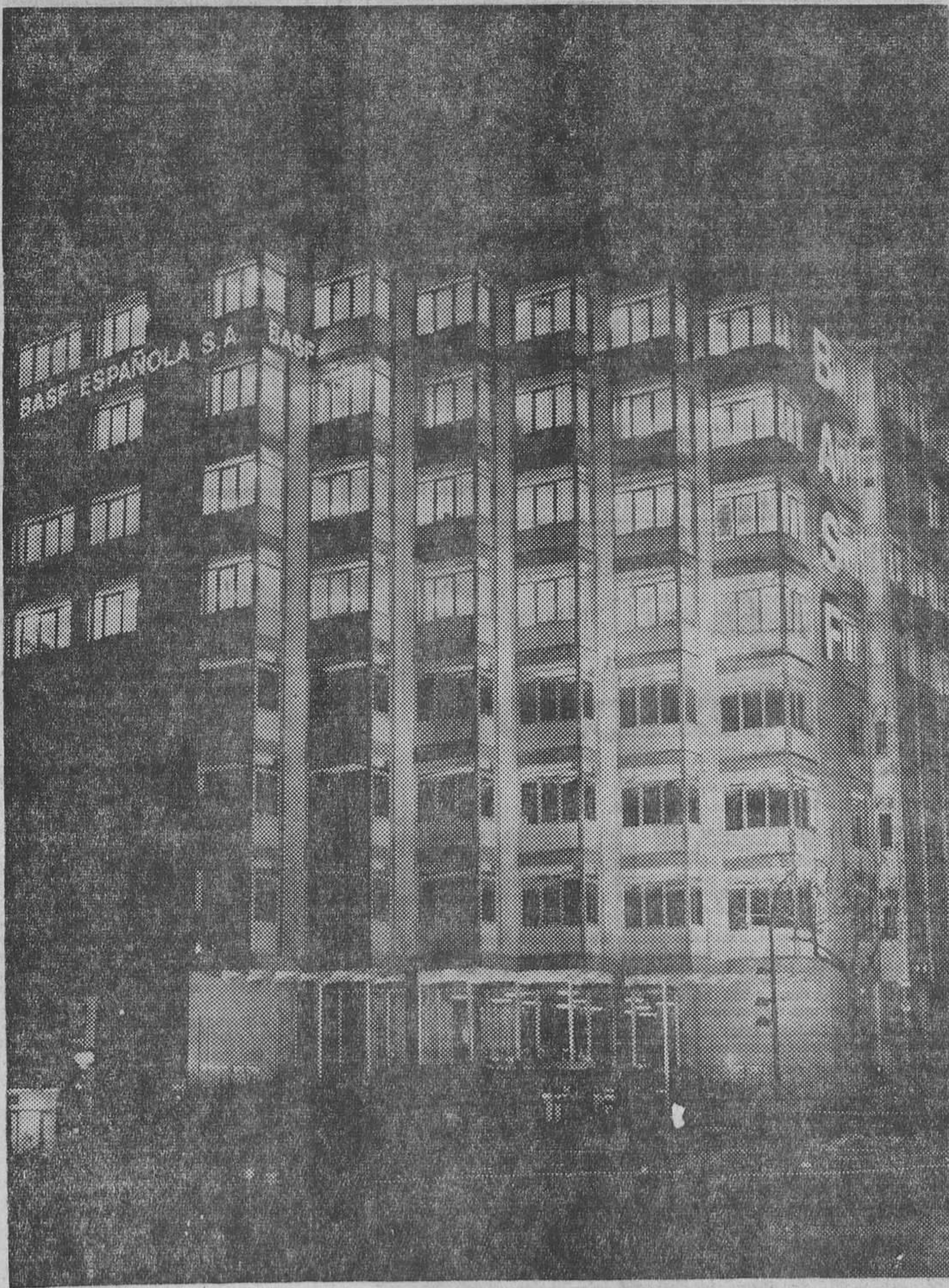
Inmueble de las oficinas centrales de «BASF Española, S. A.», sito en Paseo de Gracia, 99
