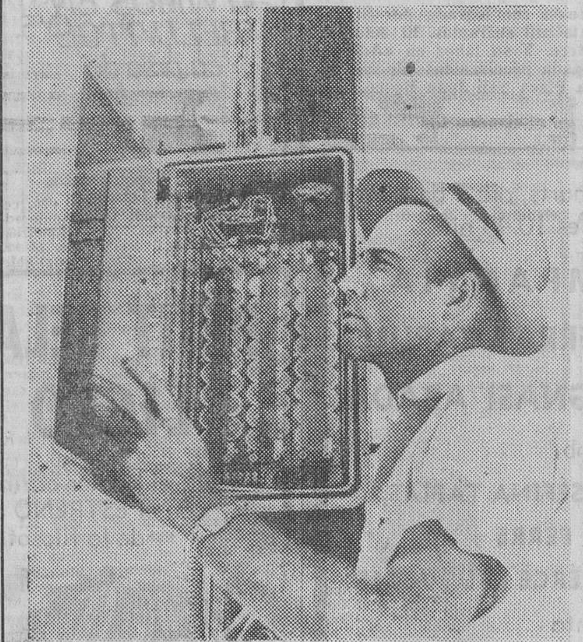
He aquí una batería que se carga con energía solar. Esta queda reservada para la noche y con ella funciona ya una línea telefónica en Georgia. — (Foto EFE)
