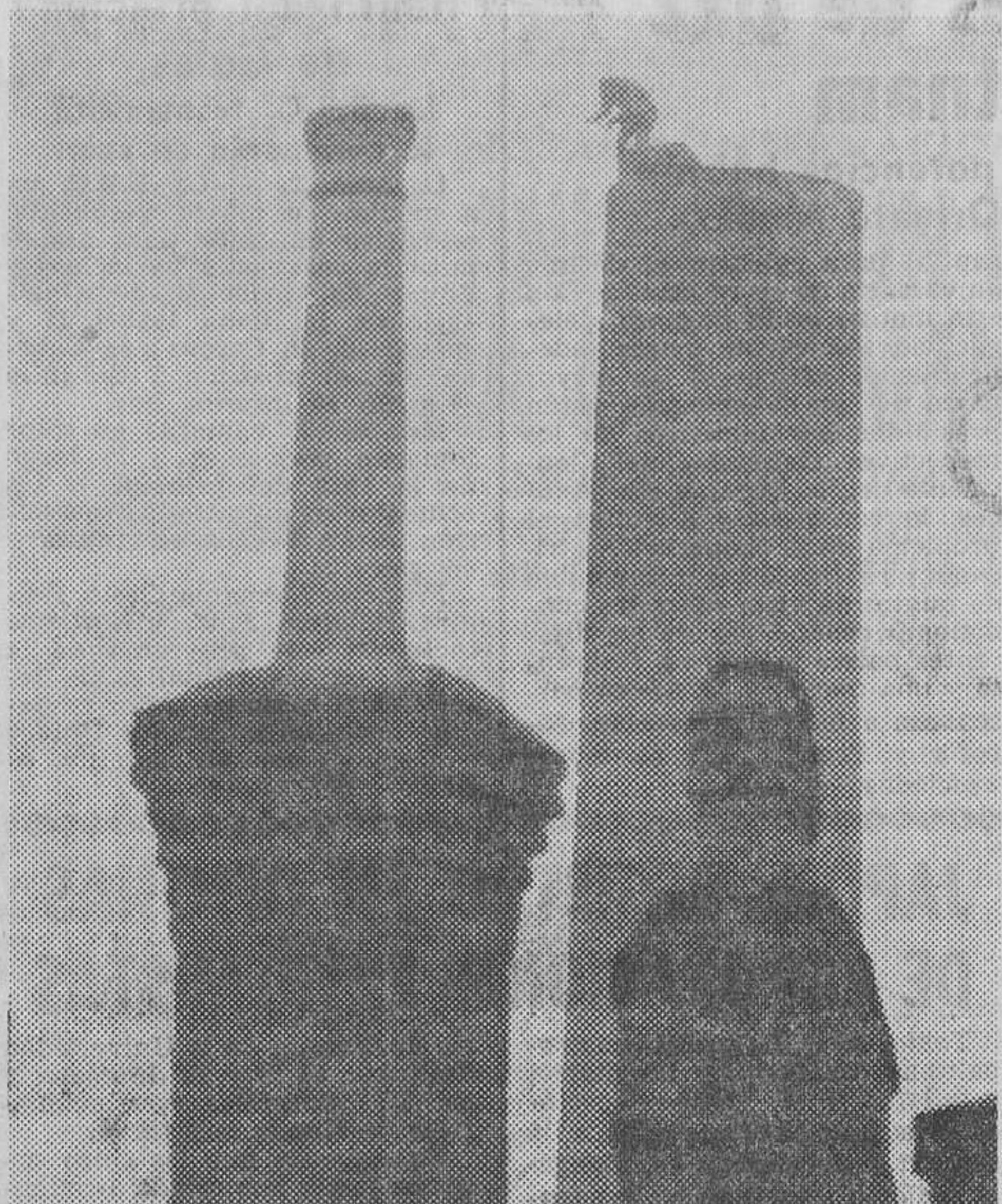
Jim Wilton pertenecía a la Marina mercante británica y dejó el mar por un trabajo más seguro. Aquí le vemos a muchos metros de altura, recortado sobre el cielo londinense, mientras se afana en la destrucción de una chimenea, con poquísimo espacio para sus pies y el abismo debajo. Por lo visto es más propenso al mareo que al vértigo. — (Foto Cifra.)
