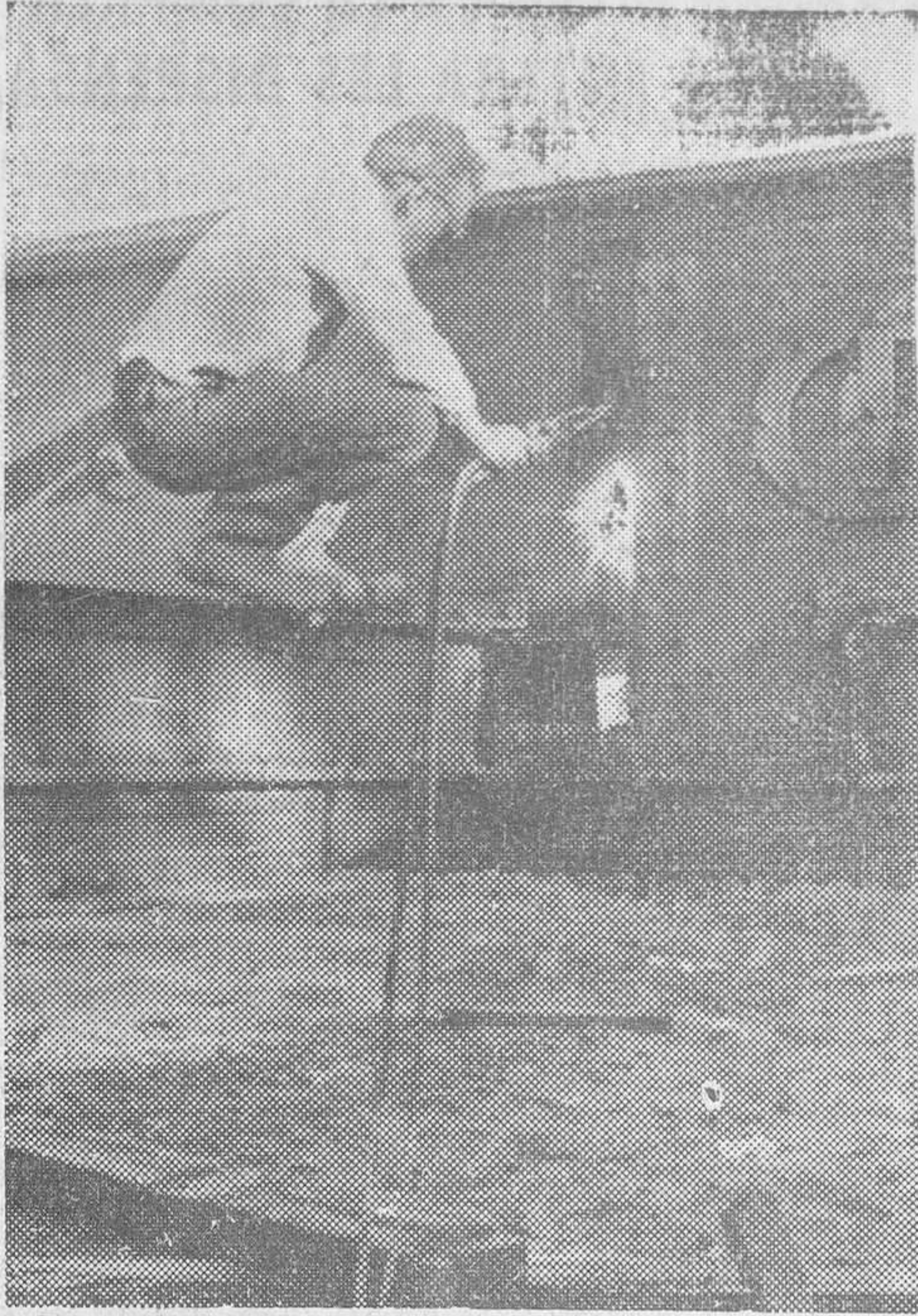
El puente de hierro de la línea ferroviaria del interior ha quedado reforzado e inservible. Con sopletes se procede rápidamente a su desguace.
