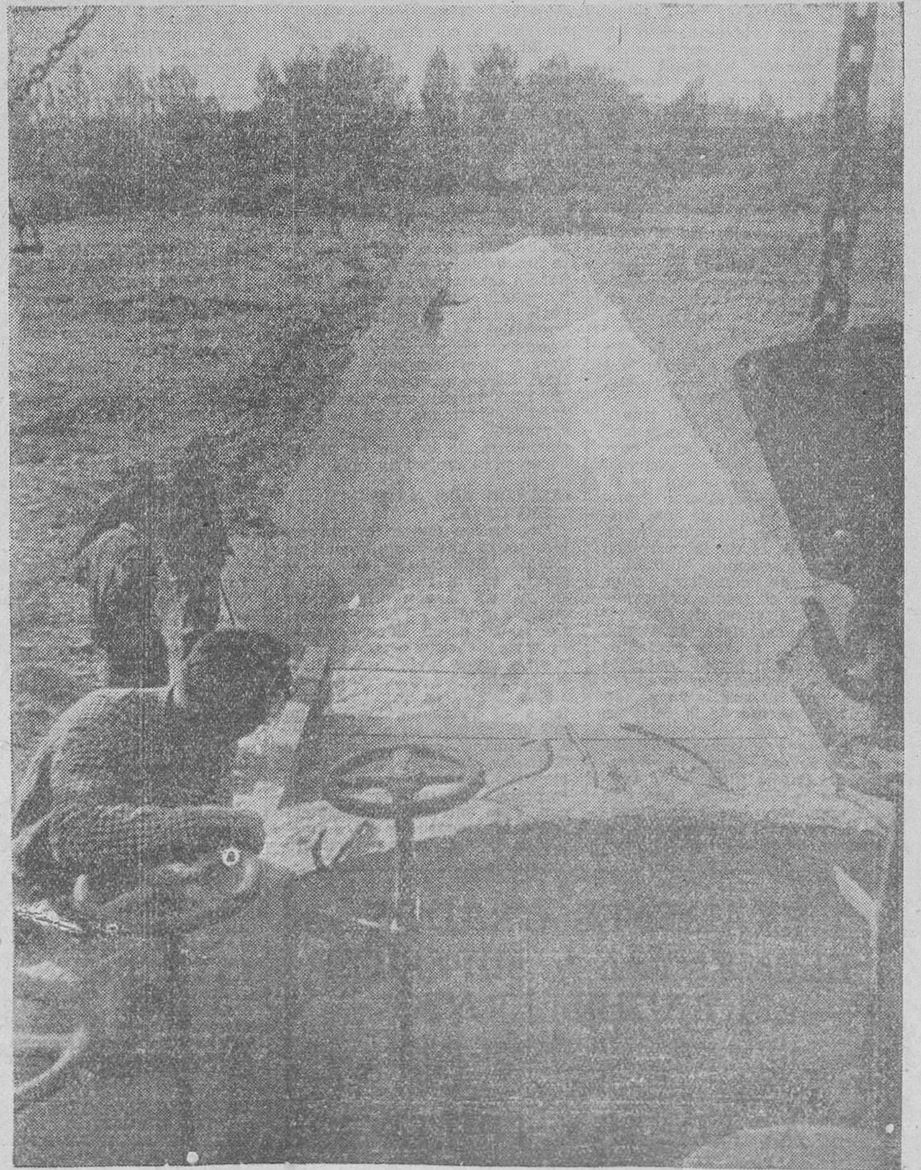
Este es el pozo Fives-Lille, de Cornellá, uno de los primeros instalados por la Empresa para la extracción de aguas y proceder luego a su traslado a las tuberías
