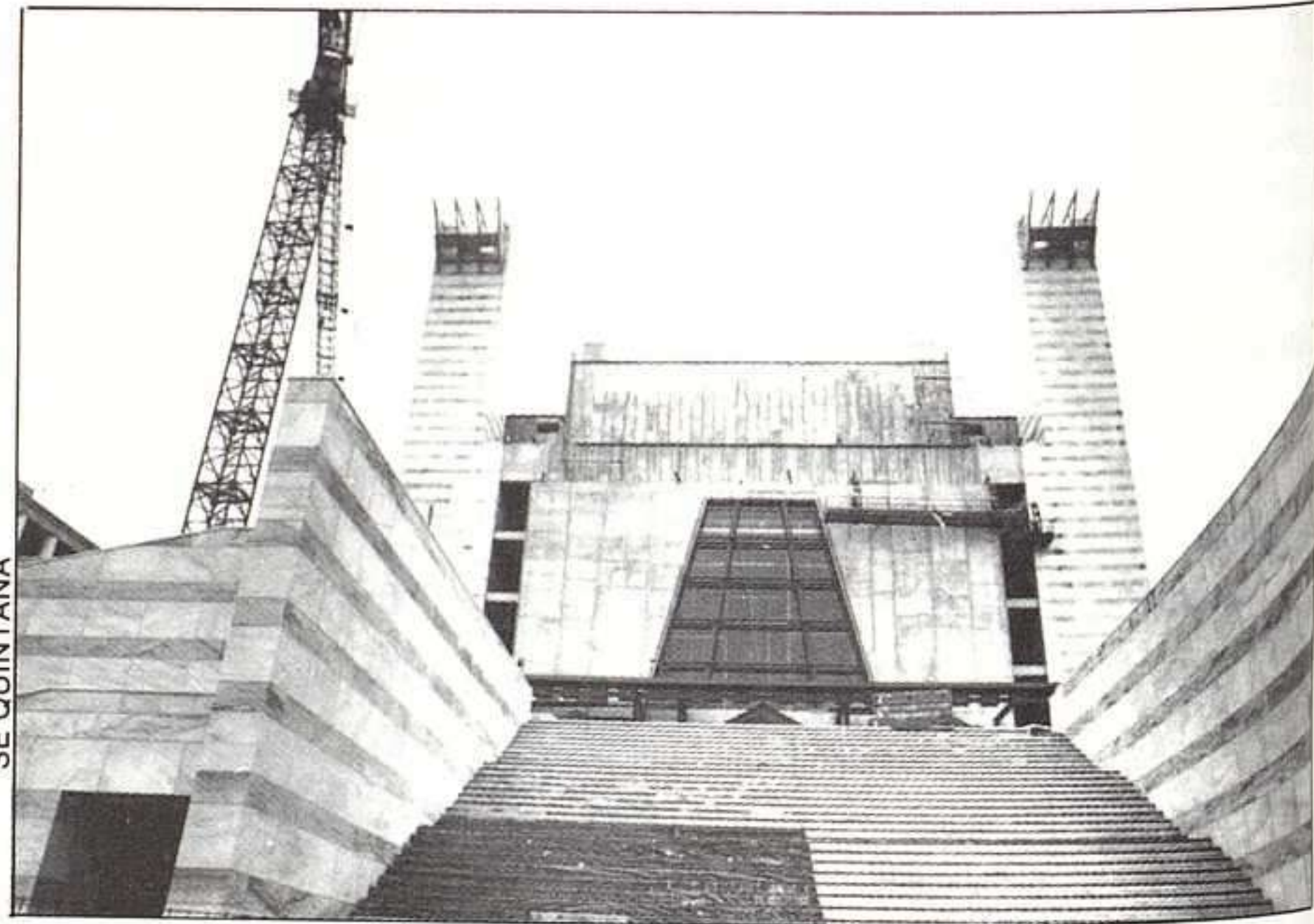
El Palacio de Festivales, en avanzada construcción.
