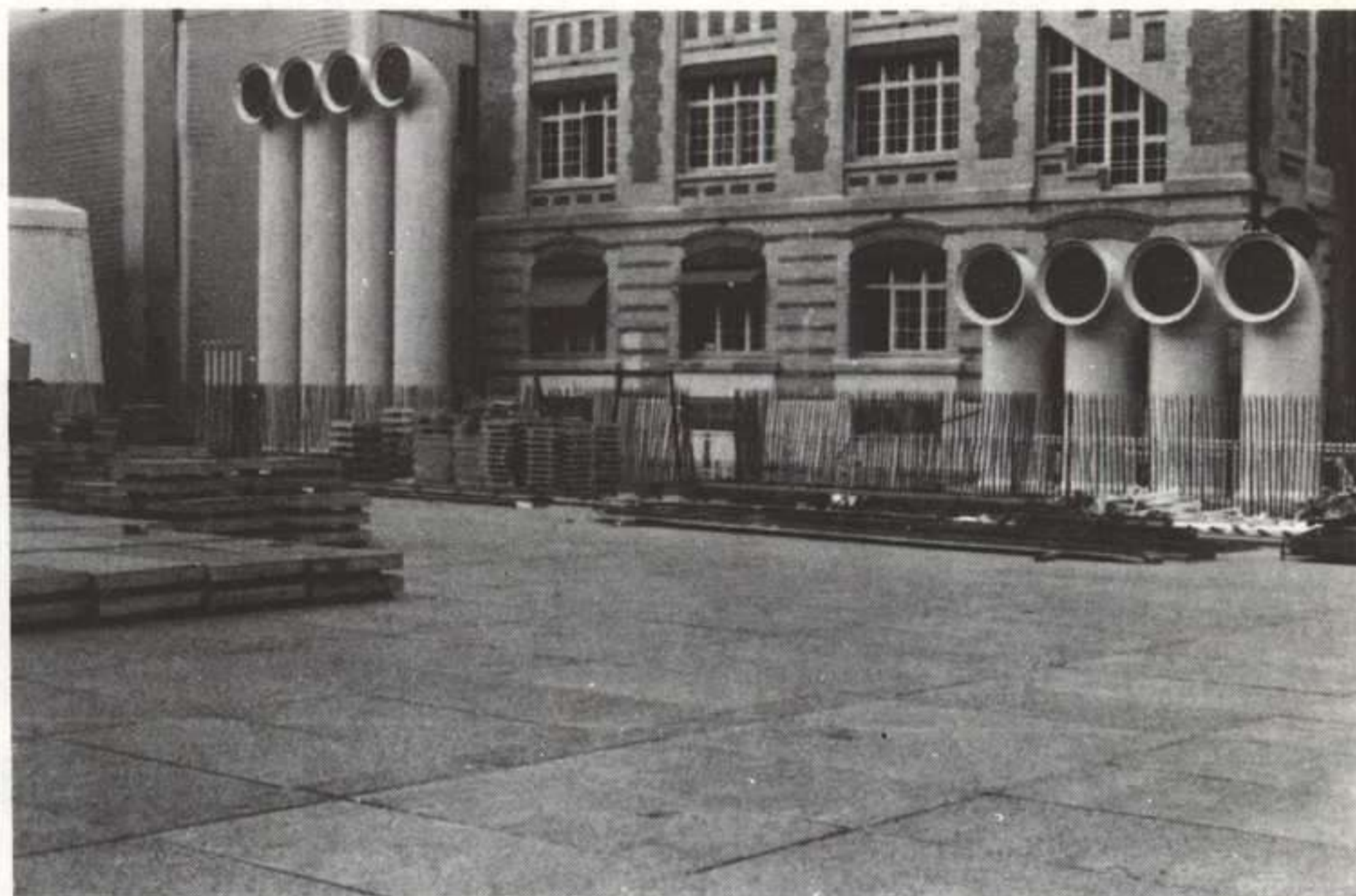
Vista parcial de lo que será la pequeña plaza construida sobre el techo del IRCAM. Al fondo, los respiraderos que forman parte del sistema de ventilación.
