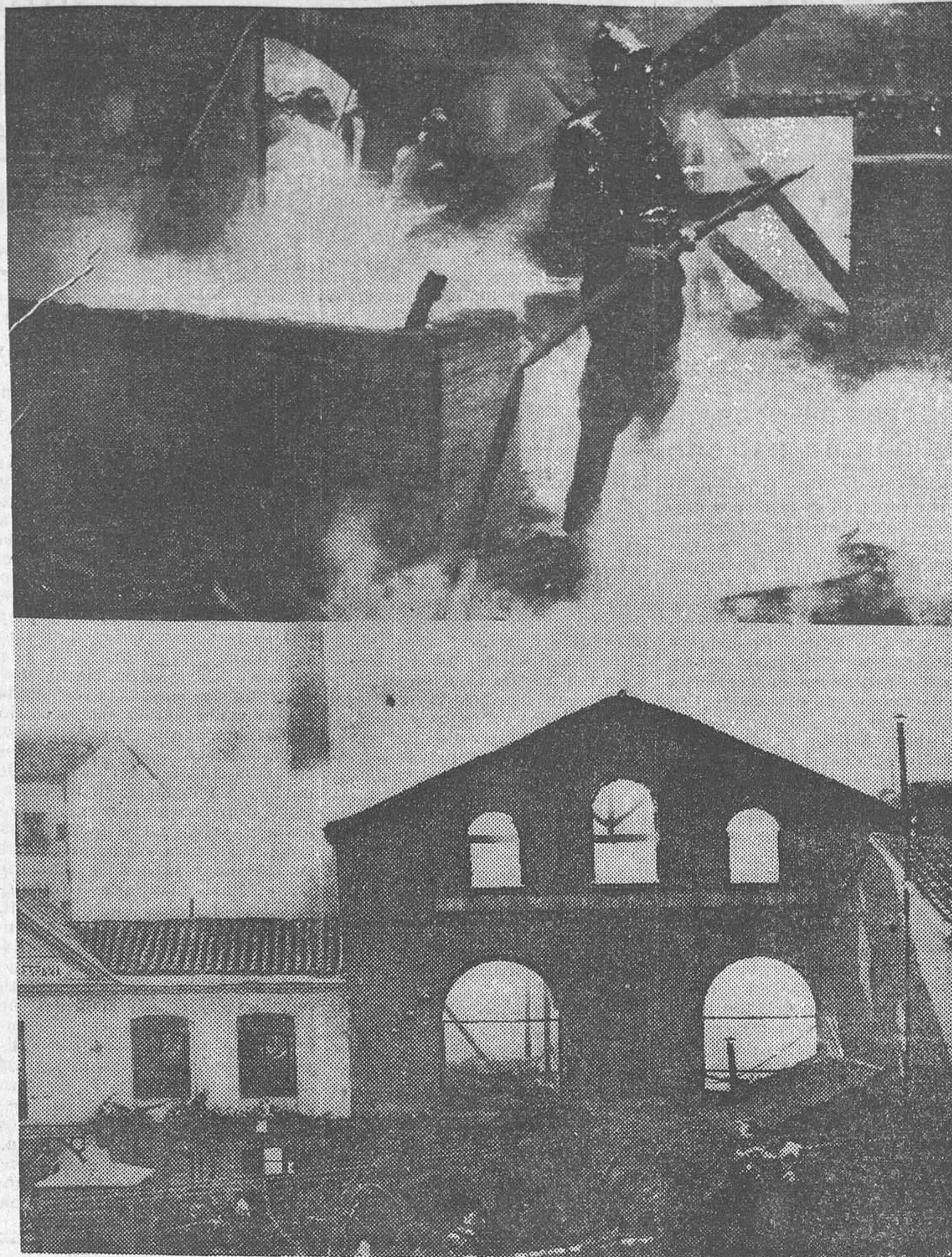
EL INCENDIO DE AYER TARDE EN LA FABRICA DE LA UNIÓN VIDRIERA.—Dos aspectos del siniestro ocurrido en el paseo de Santa María de la Cabeza, que ocasionó la destrucción total del inmueble (Fotos Alfonso.)
