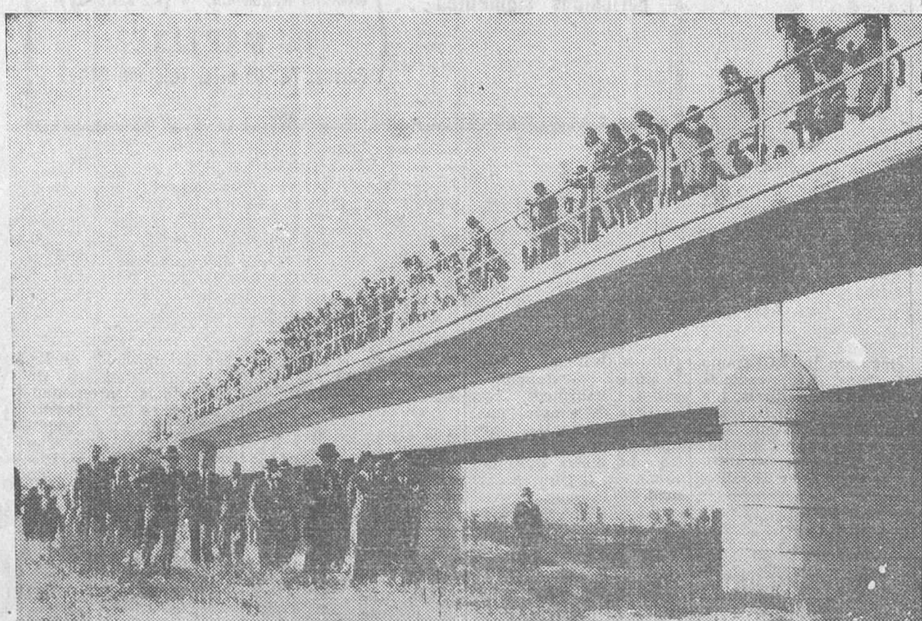
Inauguración, ayer tarde, del puente construido sobre el río Jarama, en el camino vecinal de San Martín de la Vega a la carretera de Arganda (Fot. Alfonso.)
