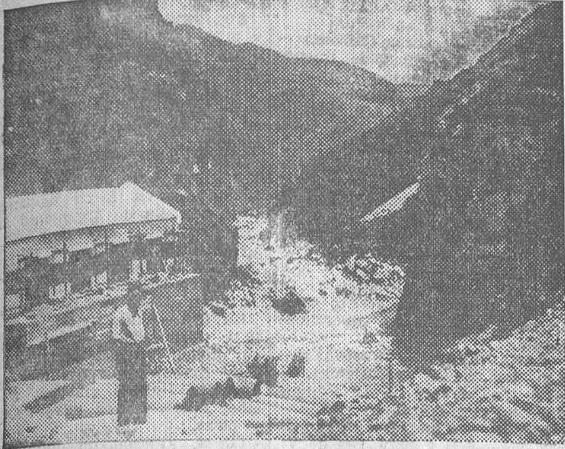
Central de máquinas.—Al fondo, cañón del Lau
