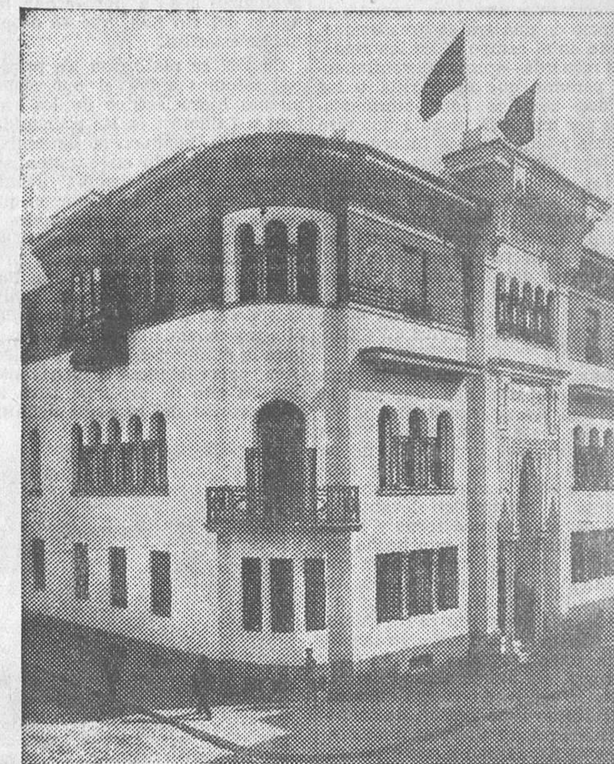
Magnifico edificio del Banco de Estado de Marruecos, en Tetuán
