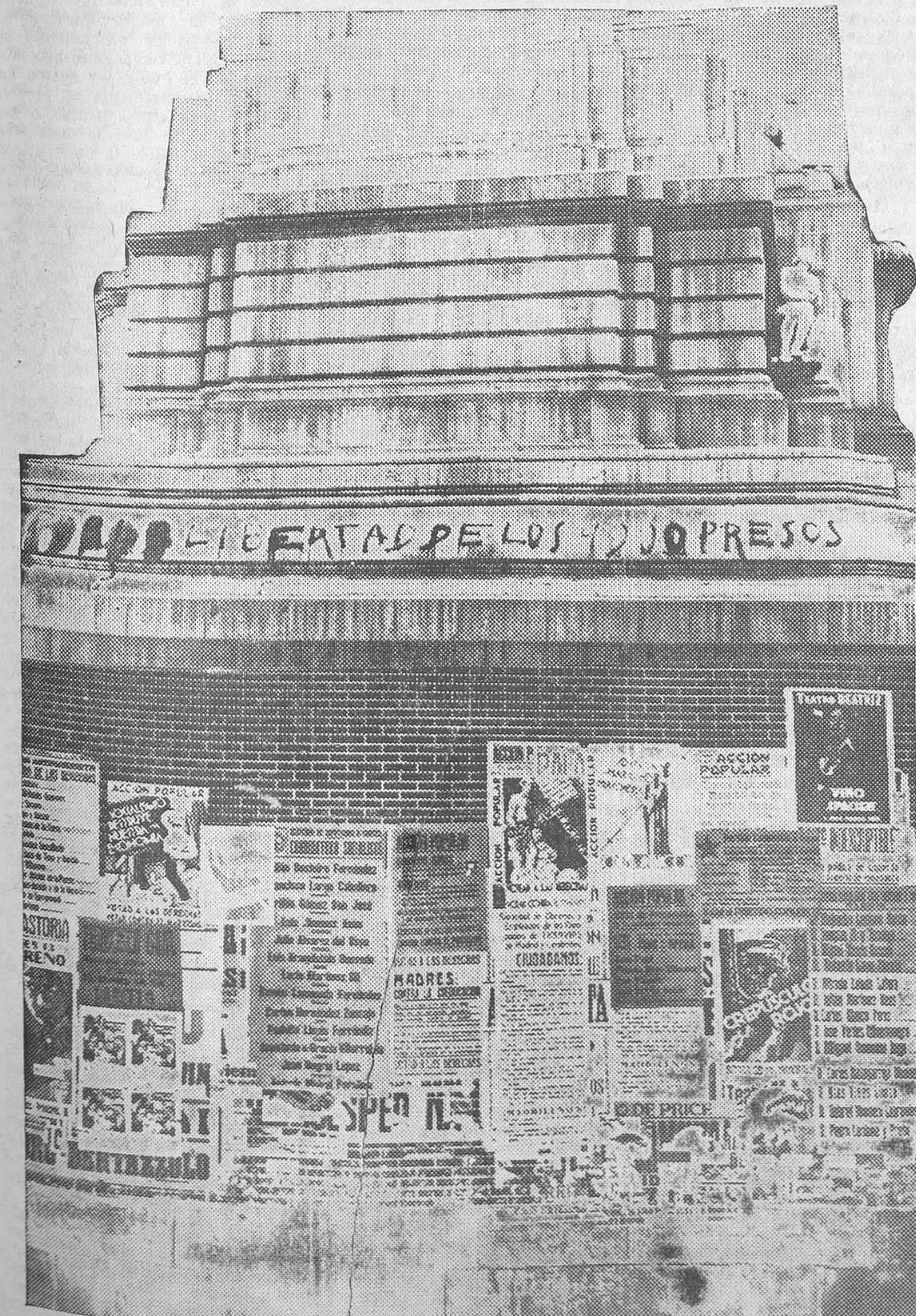
EN PLENA PROPAGANDA ELECTORAL.—Arriba, uno de los letreros con que un grupo de inconscientes «ilustró» el monumento a Cervantes de la plaza de España.—Abajo, el campo de batalla de la contienda electoral la fachada de un edificio cubierto por las candidaturas que lucharán el día 19. (Fotos Pando)
