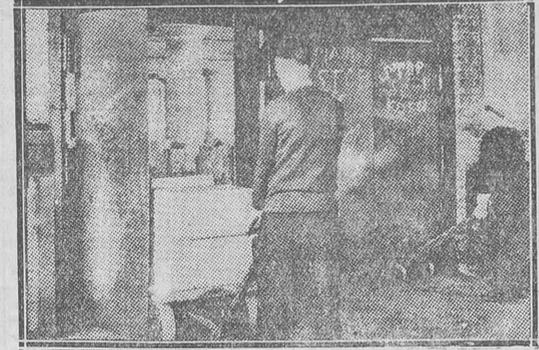
He aquí resuelto el problema de abrir y cerrar una puerta, si no a la acción de la voz, bajo la de un rayo luminoso que va a conmover una célula fotoeléctrica
