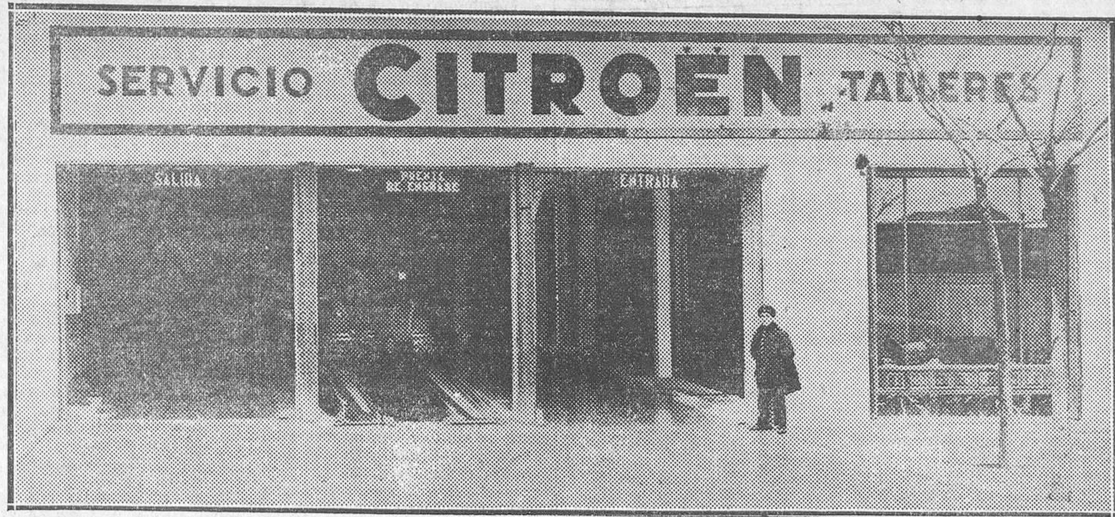
Entrada al nuevo local que para talleres ha inaugurado recientemente la Casa Citroën en la calle de Goya, 113
