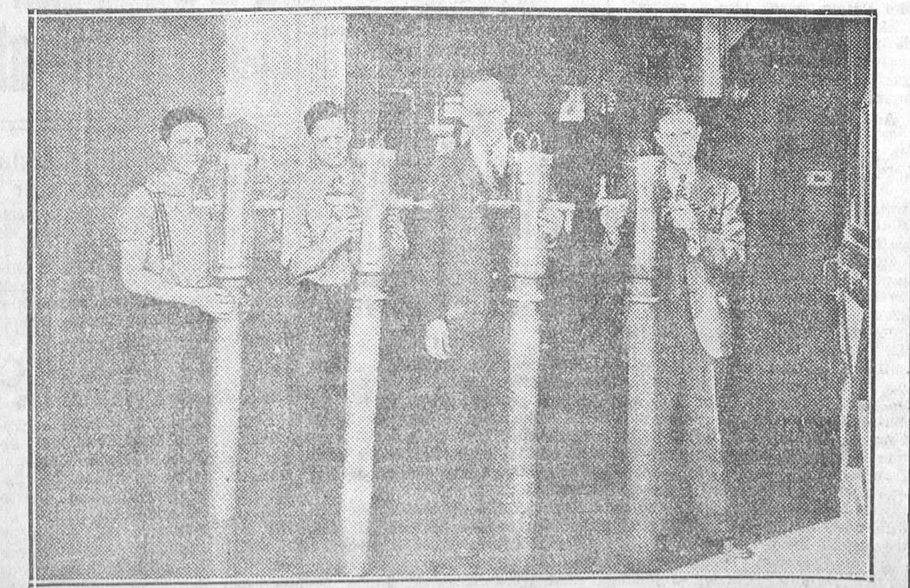
Estas lámparas de cien kilowattios, para emisoras, constituyen una de las recientes creaciones de la ciencia radioeléctrica
