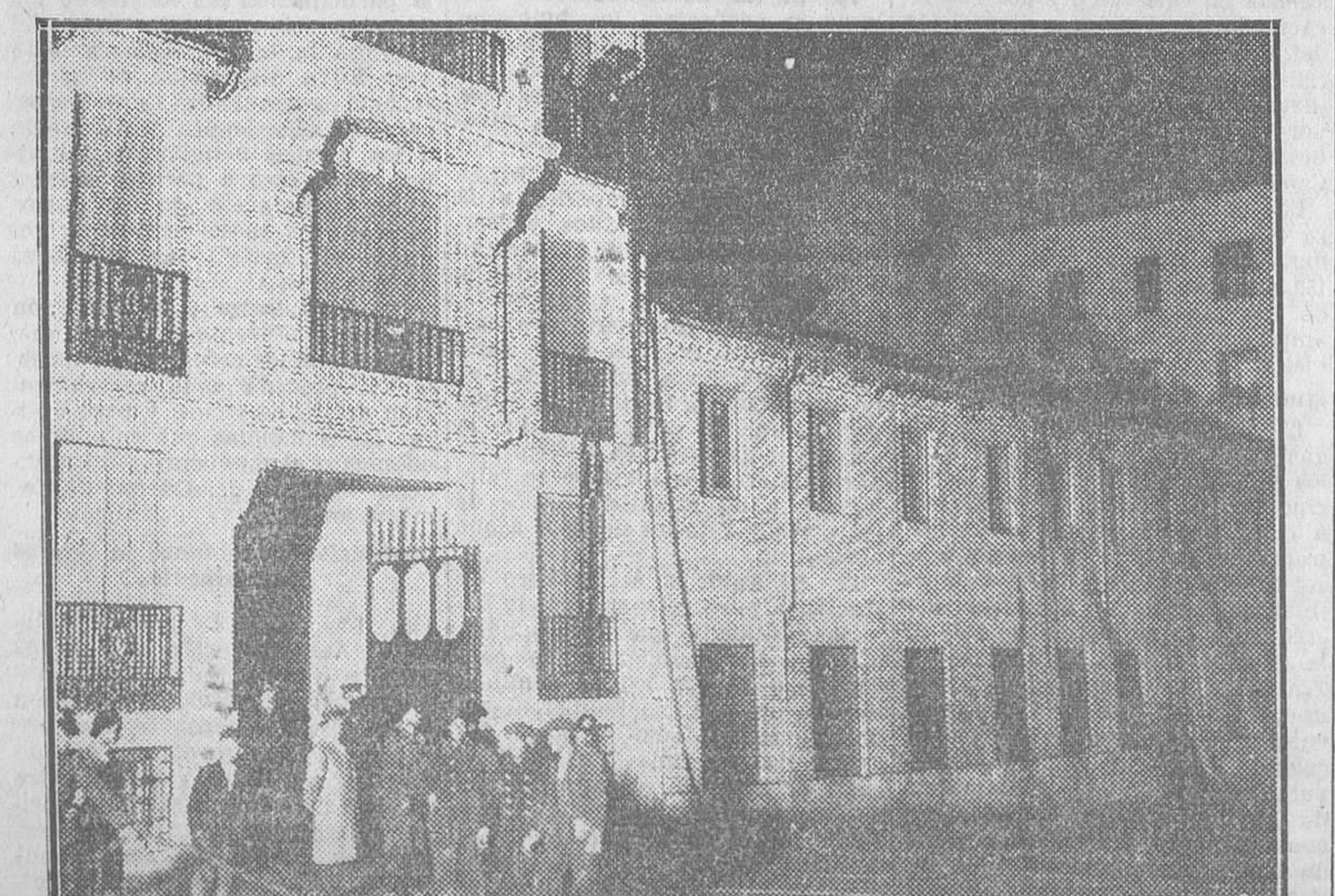
EL INCENDIO DE ANOCHE.—Entrada principal del edificio siniestrado. Los bomberos arrojando espuma sobre el fuego, presa de las llamas (Fot. Alfonso.)
