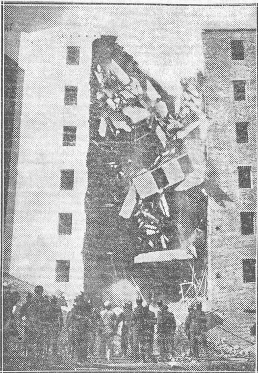
Derrumbamiento de una medianera de la casa en construcción de la calle de Alonso Cano, poco después de producirse el hundimiento que causó las víctimas (Fot. Alfonso.)
