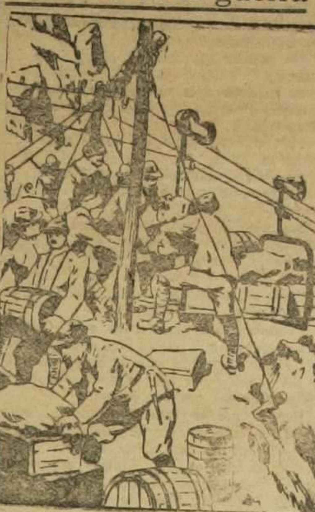
Estación austriaca de aprovisionamiento en los aldeaños de los Alpes
