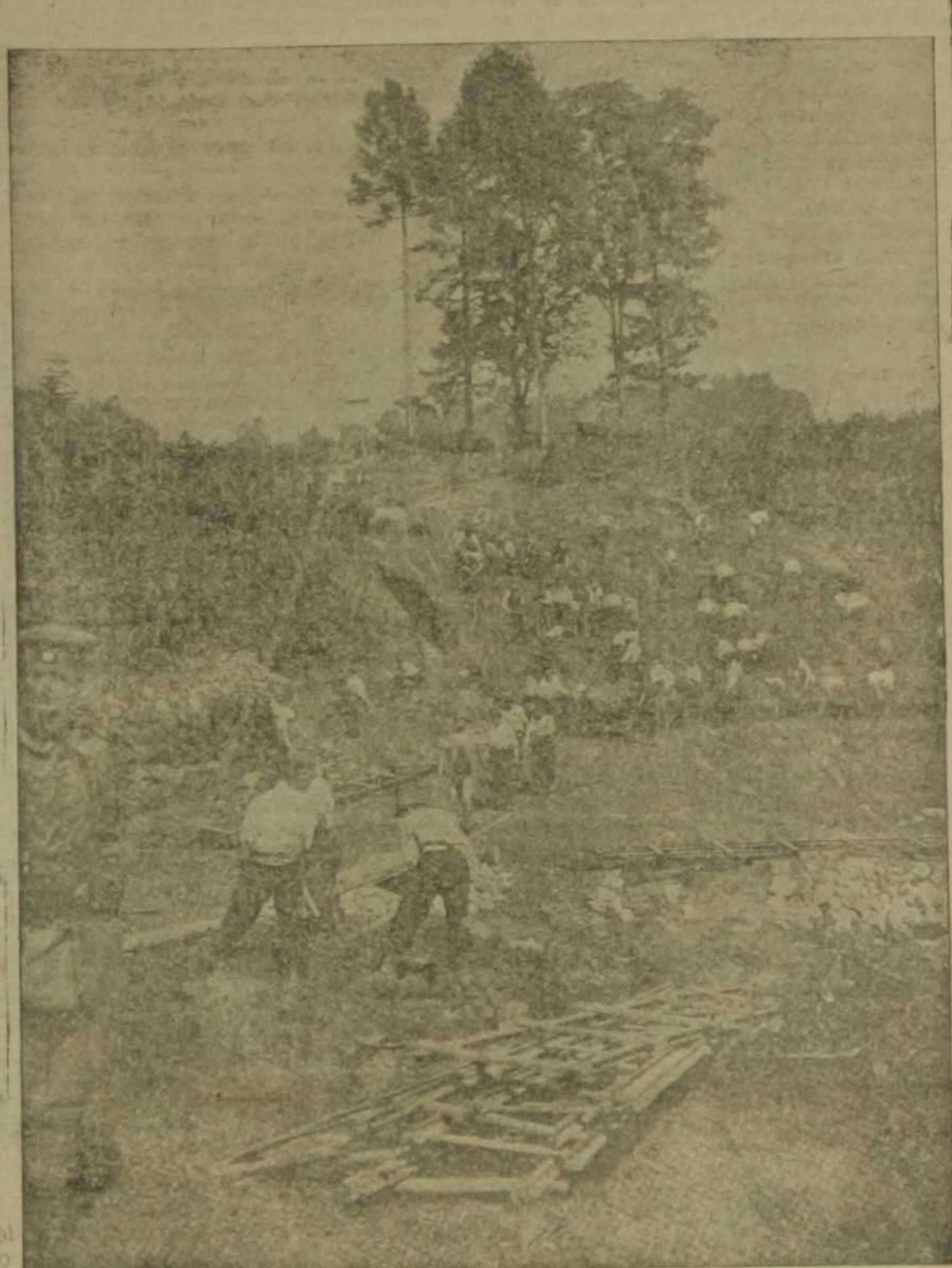
Prisioneros franceses reconstruyendo, bajo la dirección de oficiales de ingenieros alemanes, una línea de ferrocarril destruida por las tropas aliadas, cerca de Montmedy
