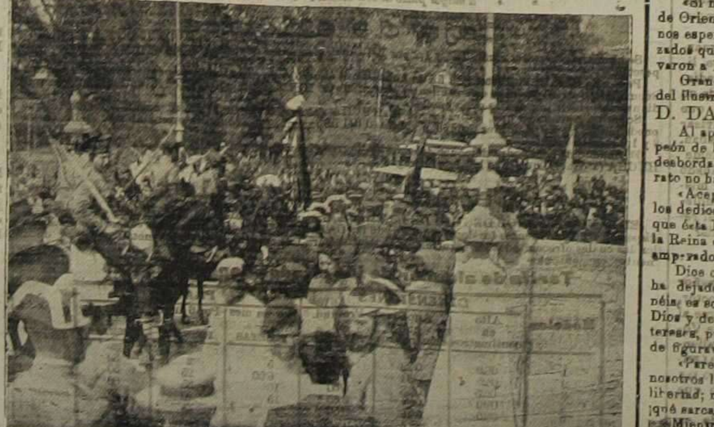
El incidente a la entrada del puente del Real
