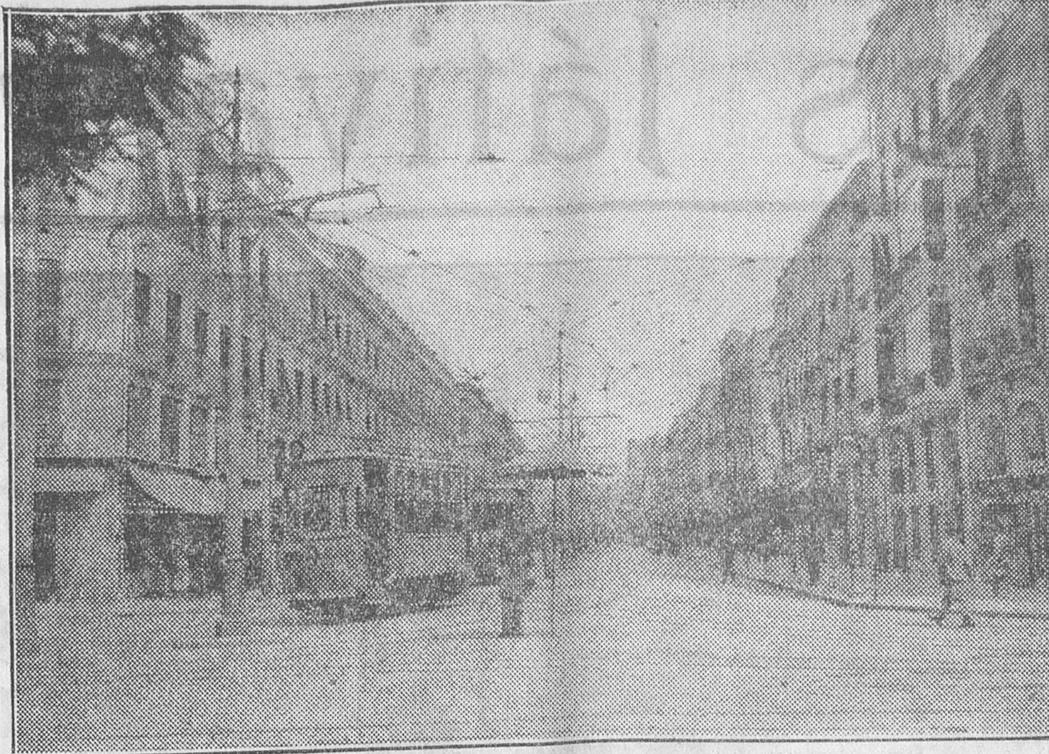
CALLE DE COLÓN-VISTA PARCIAL
