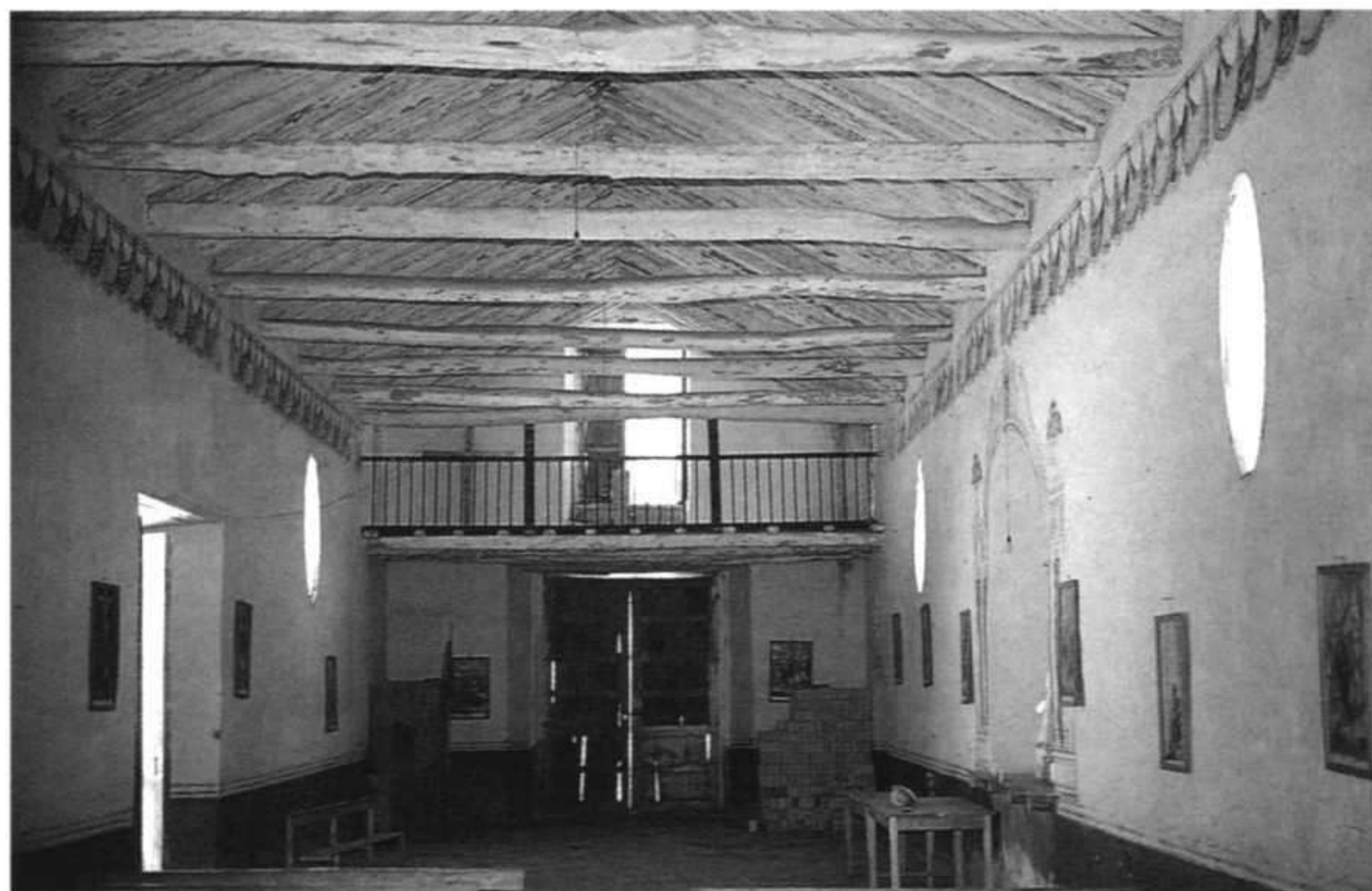
Fig. -2: Vista del interior de la iglesia de Susudel.
