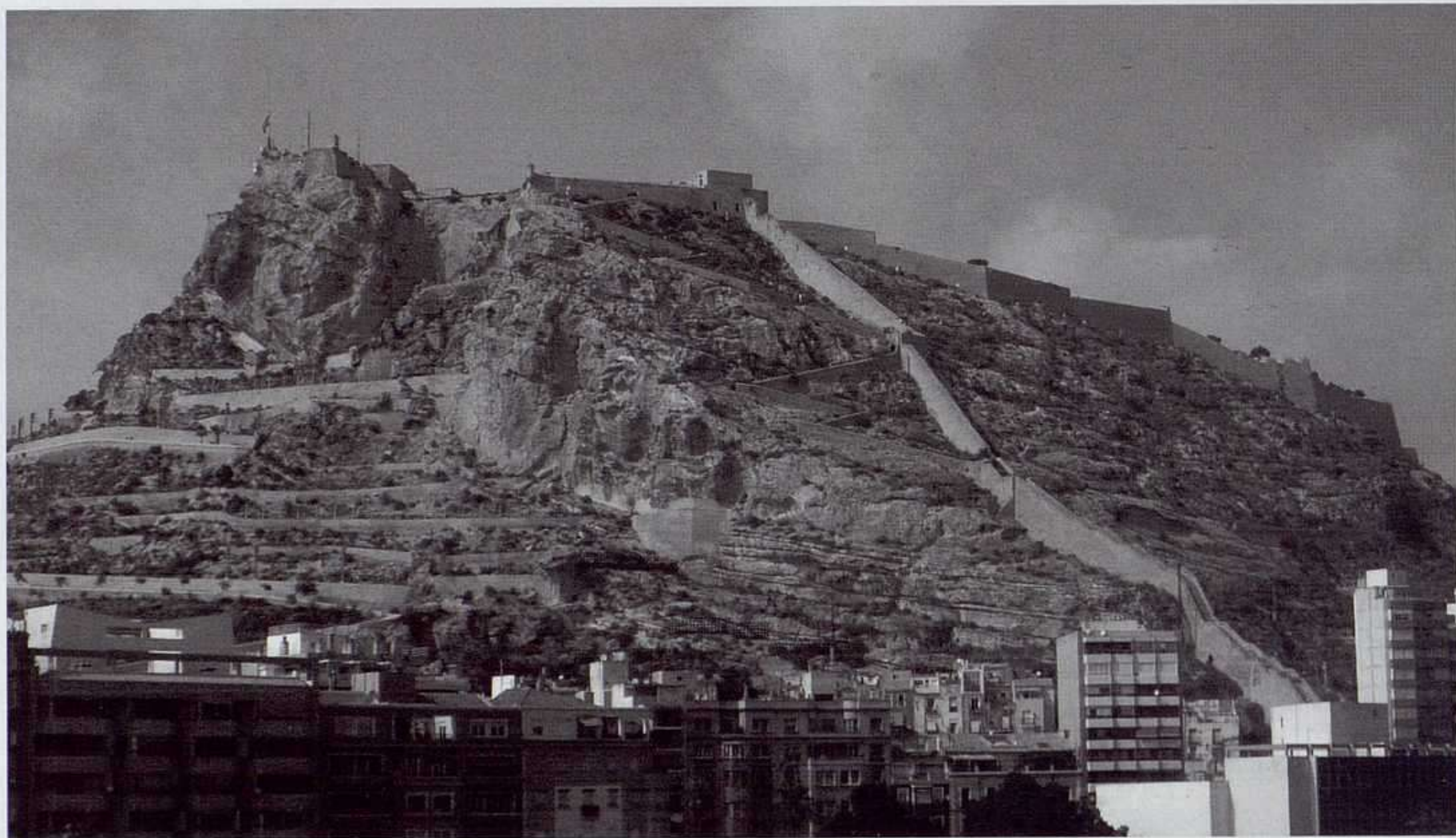
Vista del Castillo de Santa Bárbara, Alicante.
