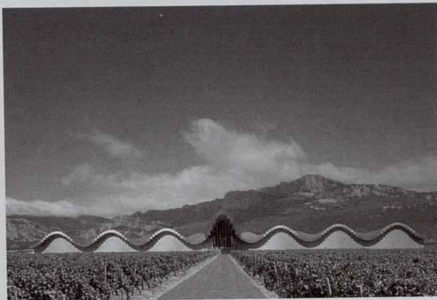
Santiago Calatrava: Bodega Ysios, Laguardia, Álava, 1998-2001.
